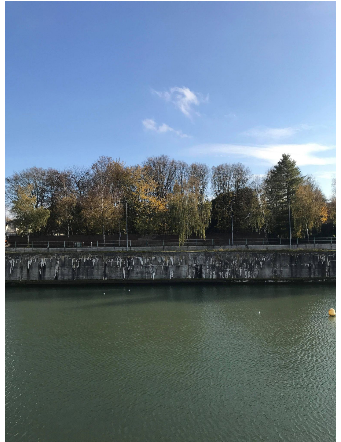
Illustration 6 La façade côté Scarpe
