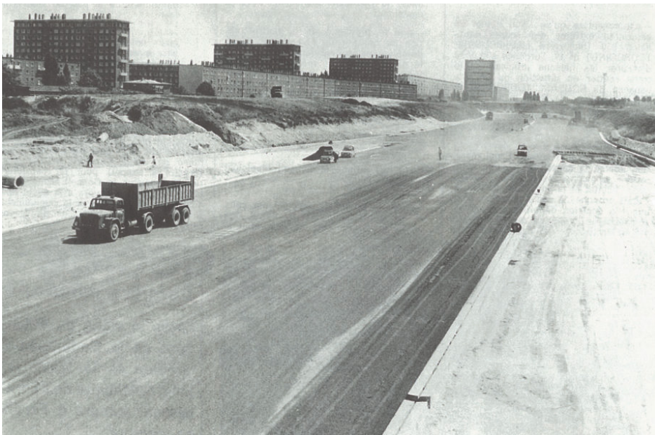
Fig 46: Construction de l'autoroute sur l'espace agricole
