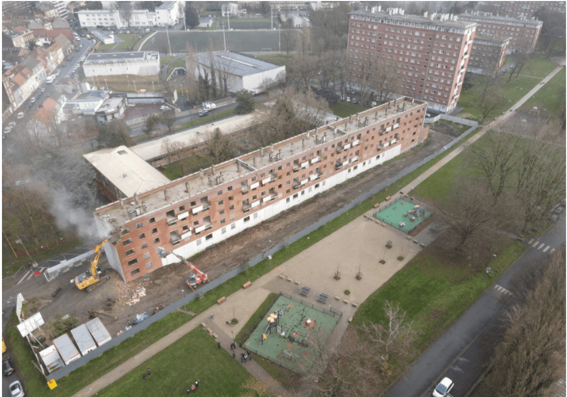
Fig 5 : Destruction de la première barre à Concorde La barre 2-12, à l'Ouest du site, est pour l'instant la seule détruite
