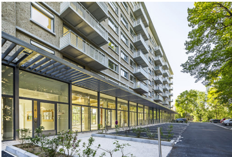
Fig 101 : Installation d'un socle actif, et de continuités à l'inverse des résidentialisations
