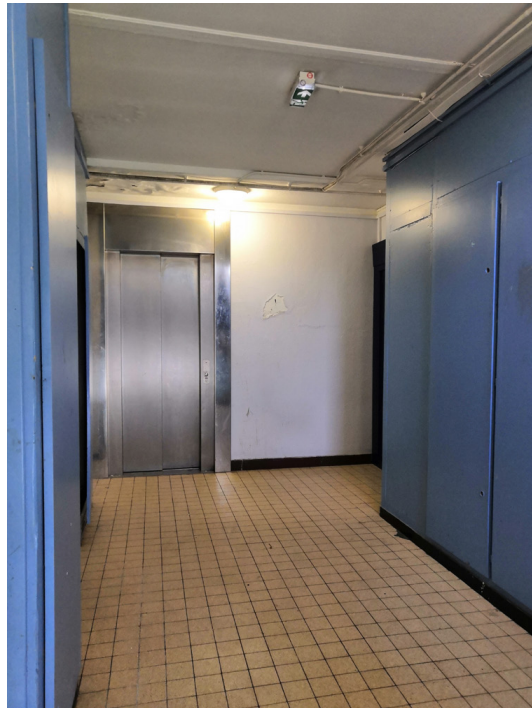
Espace de desserte des appartements entre les gaines verticales, l'ascenseur, et l'escalier, seul côté disposant de fenêtres
