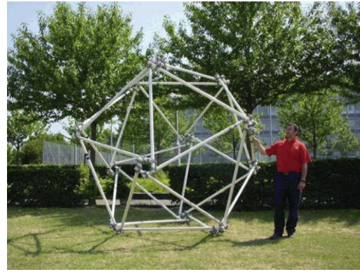
Figure 6 : Structure réciproque cylindrique composée de modules avec paramètres initiaux indépendants (gauche), structure réciproque sphérique composée de modules avec paramètres initiaux dépendants (droite) [3]
