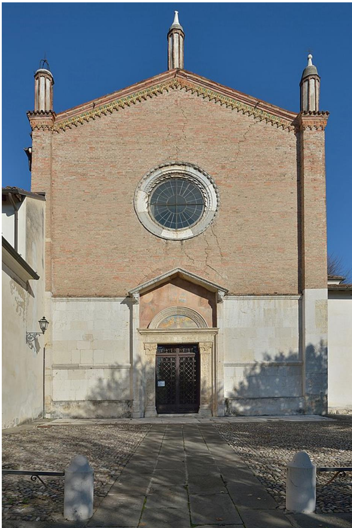
Fig. 58. Brescia, Eglise de Santissimo Corpo di Cristo , XV-XVIII. Façade sud . Etat en 2015, cliché de Wolfgang Moroder. (© Wikipedia, 2015, [ https://bit.ly/4fhkBuL ], (consulté le 15/07/2024).
