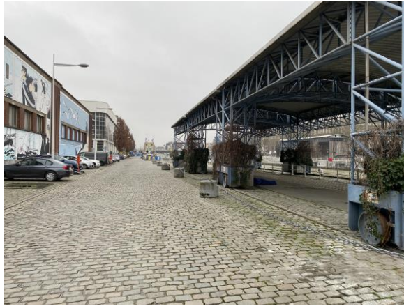
Figure 17 : Le quai des Péniches ; des fresques mais des rez-de-chaussée non actifs et un espace public très peu activé
