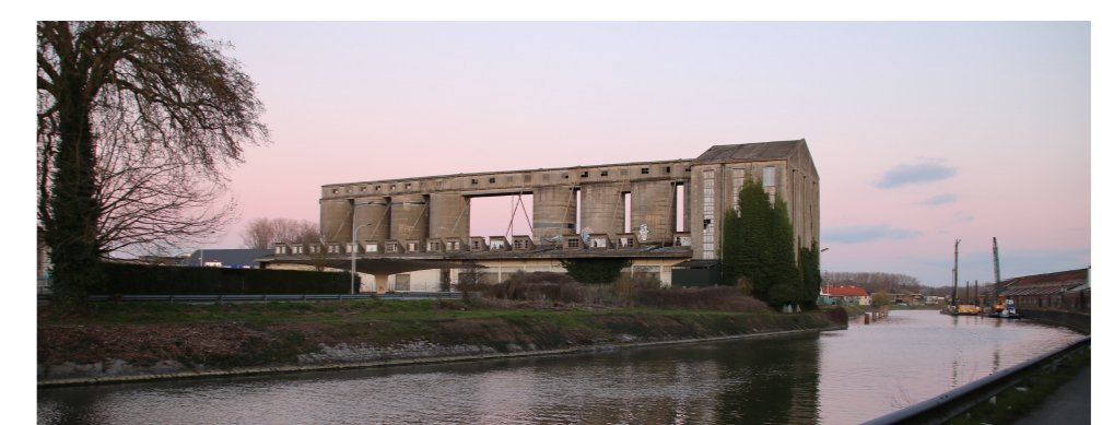
Application sur les Silos des Bastions à Tournai
