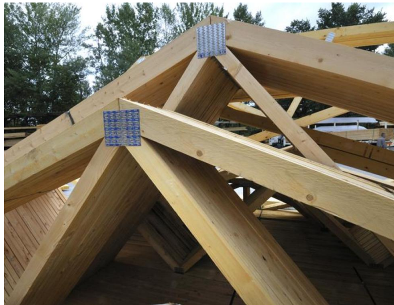
FIGURE 3.17 – Ferme assemblée à l'aide de connecteurs métalliques [57]
