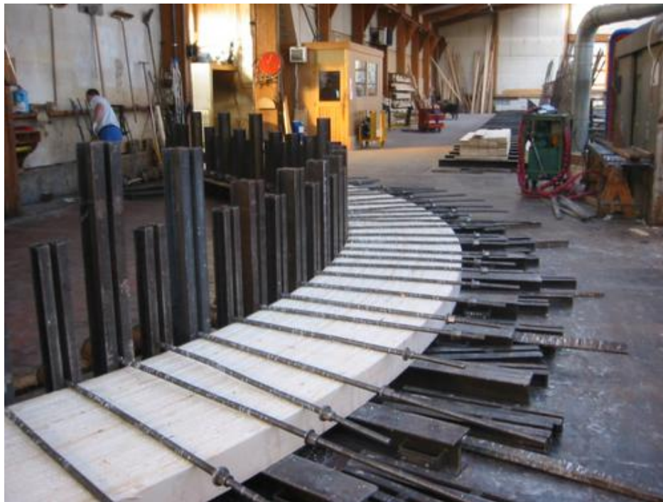
FIGURE 3.9 – Poutre courbe BLC sur banc de serrage [38]
