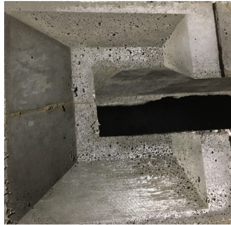
FIGURE 4.3 – État de surface obtenu relativement correct
