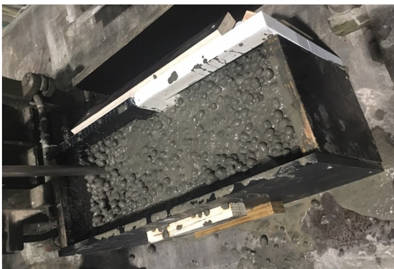
FIGURE 4.8 – Vibrage du béton à la tige. Les billes d'Argex remontent et si aucun contrôle n'est fait, entraînent un mauvais état de surface
