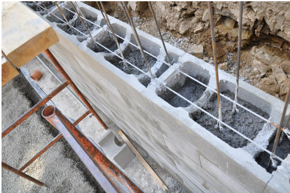
FIGURE 4.13 – Blocs armés Stepoc remplis de béton frais [17]
