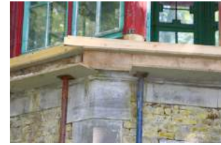
Fig. 87 – Nouvelle dalle béton
