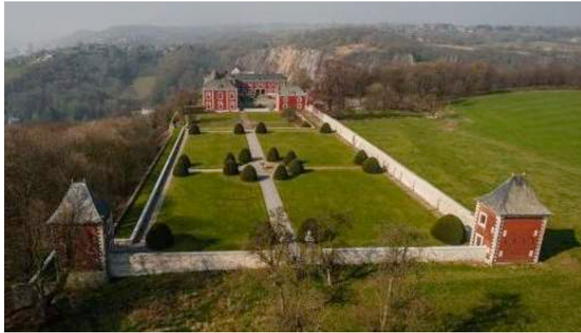
Figure 30 : Paires de hauts pavillons en limite de la terrasse supérieure des jardins du château d'Aigremont
