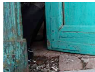
Fig. 94 – Pavés manquants
