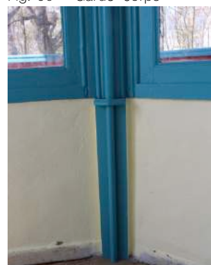
Fig. 70 – Moulure d'angle
