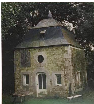
Figure 32 : Cabinet de maçonnerie du château de Mianoye à Assesse
