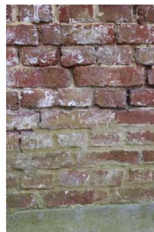
Fig. 77 – Joint lavé – rejointoiement
