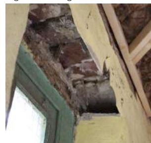
Fig. 96 – Linteau manquant
