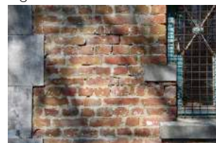
Fig. 47 – Appareillage brique
