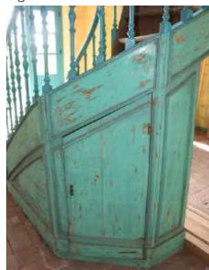
Fig. 64 – Espace sous escalier
