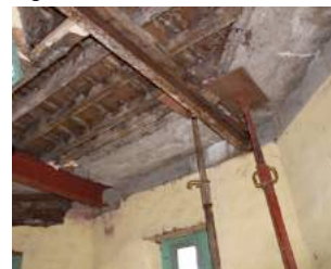
Fig. 66 – Poutres métalliques
