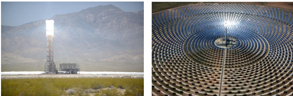
Figure 10 - Centrale à tour d'Ivanpah (gauche) et de Gemasolar (droite) dans la région de Séville (Espagne). [75]
