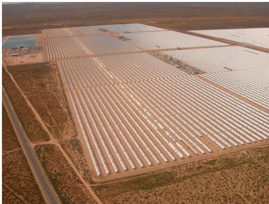
Figure 11 – Gauche : Centrale à concentration cylindro-parabolique : Solar Energy Generating Systems. Droite : Concentrateur cylindro-parabolique de la centrale Nevada Solar one. [75]
