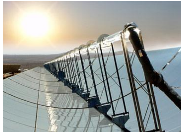
Figure 11 – Gauche : Centrale à concentration cylindro-parabolique : Solar Energy Generating Systems. Droite : Concentrateur cylindro-parabolique de la centrale Nevada Solar one. [75]
