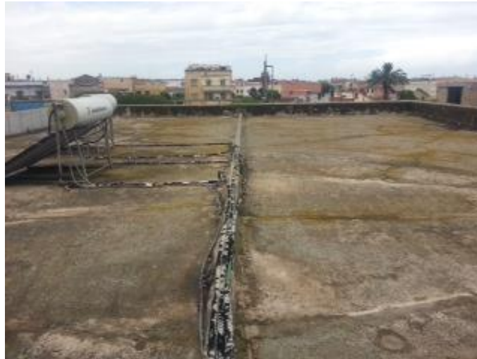
Figure 15 - Photographie du toit de l'entreprise Blancatex : 2 surfaces d'environ 8 x 15 m
