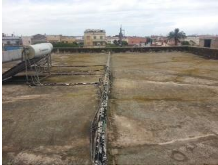
Figure 59 - Photographie du toit de l'entreprise Blancatex : 2 surfaces d'environ 8 x 15 m
