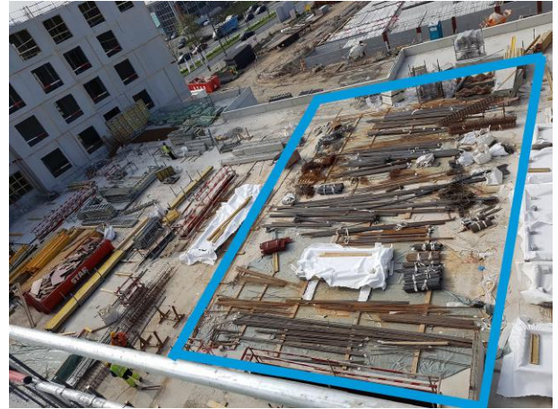
FIGURE 35 – Aperçu du stock d’armatures sur le chantier City Dox
