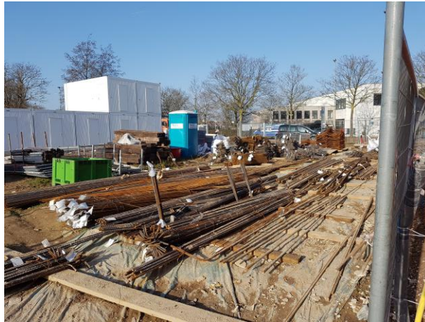
FIGURE 14 – Stock type sur un chantier de construction
