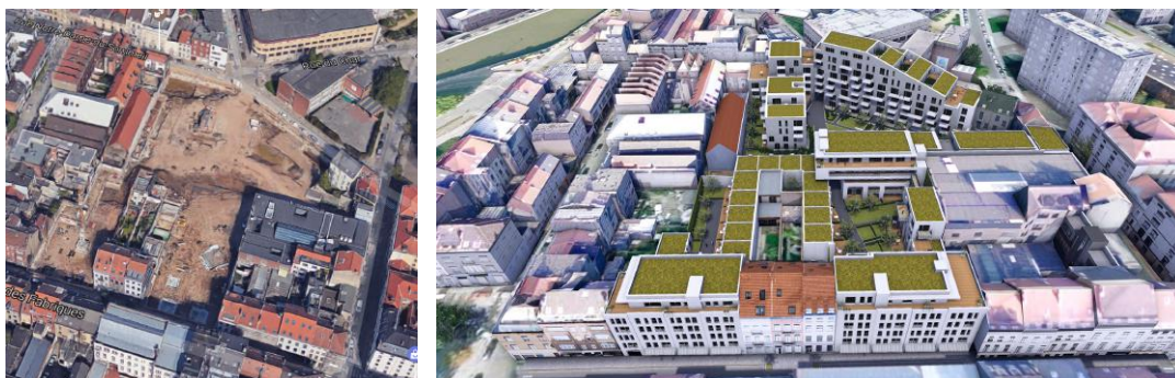
Site de construction et rendu du projet Canal District
