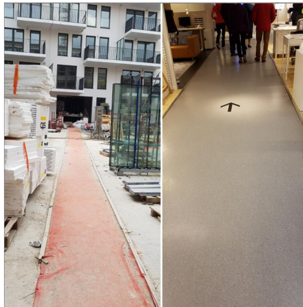
FIGURE 57 – Circulation interne organisée visuellement sur le chantier de Canal District (Bruxelles) sur la droite, inspiré notamment par l'agencement des magasins Ikea sur la gauche
