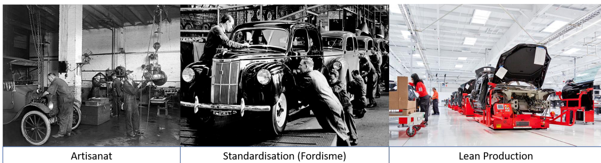
FIGURE 3 – L'évolution de la production de voitures depuis 50 ans. L'artisanat a laissé place à la standardisation du travail et aux lignes de production avec Ford pour ensuite se diriger vers le Lean appliqué alors chez Toyota ou encore Tesla
