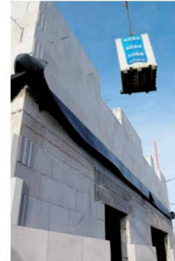
FIGURE 22 – Palette de blocs silico-calcaire déchargée directement sur chantier
