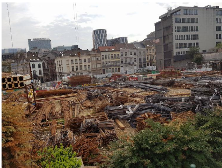
FIGURE 6 – Zone de stockage sur le chantier The One (Valens) en plein cœur du quartier Européen (Bruxelles).
