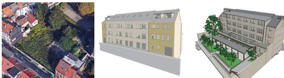
Site de construction et rendus du projet Saint-Boniface
