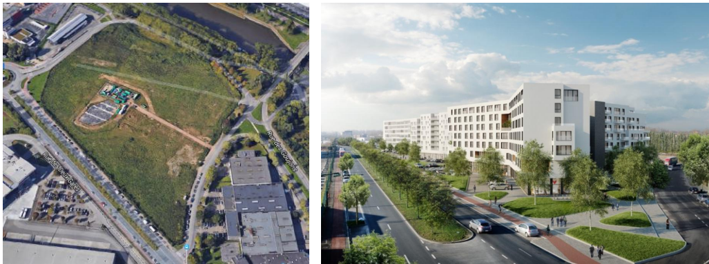
Site de construction et rendu du projet City Dox
