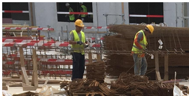
FIGURE 25 – Réalisation de l'assemblage du ferrailage d'une poutre/colonne
