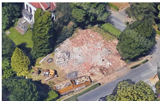
Site de construction du projet Foestraets
