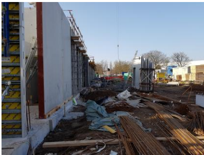
FIGURE 11 – Stock d'armatures en bordure de chantier
