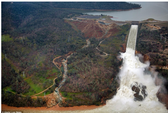
FIGURE 1.4 – Barrage d’Oroville aux Etats-Unis. Source : [Collman, 2017]
