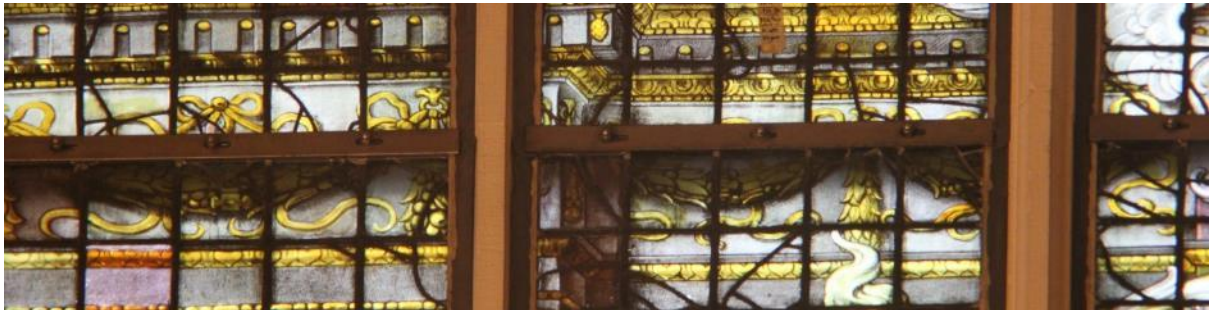
Détail de l'entablement du premier registre. Vitrail de Léopold-Guillaume (1654).
