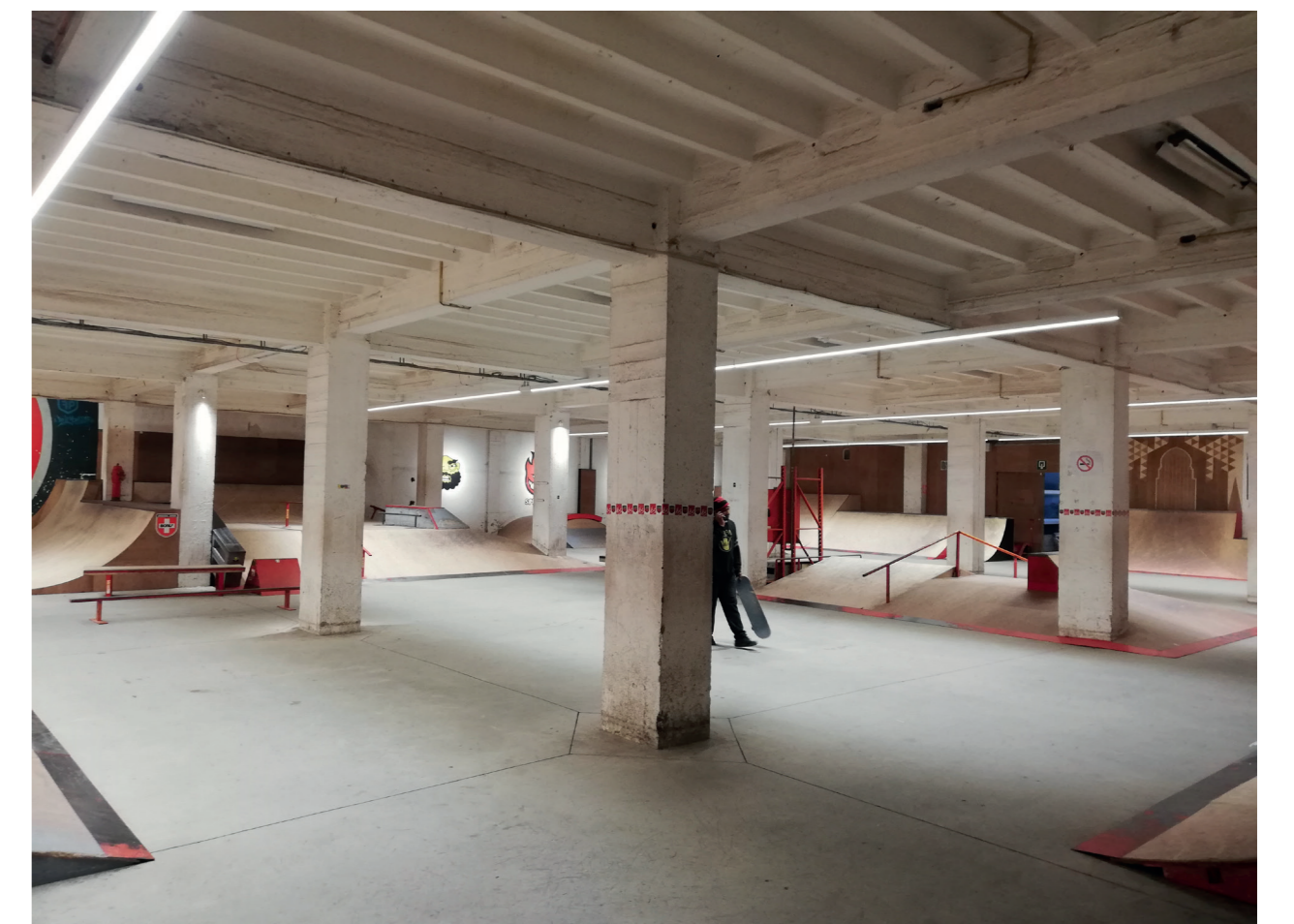
Éléments structuraux en béton armé
