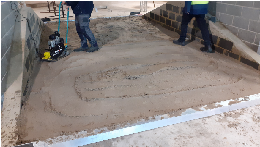
FIGURE 4.15 – Compactage du sable à l'aide d'une plaque vibrante.
