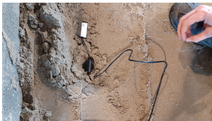
FIGURE 4.5 – Placement d'un humidimètre.
