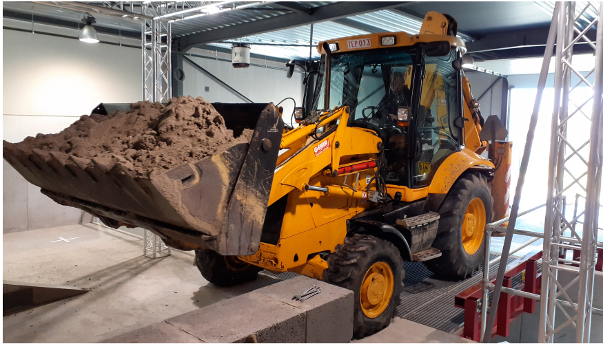
FIGURE 4.14 – Chargeur sur pneus apportant le sable.
