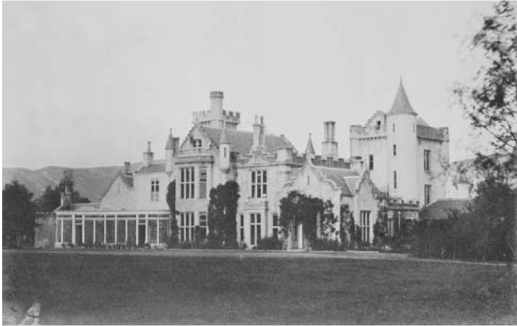
Fig. 49. Entre Braemar et Ballater, Balmoral Castle, 1853-1856, John Smith, vue du sud avec la tour du XVII e siècle et des additions réalisées par John Smith pour Sir Robert Gordon. État en 1854. Auteur du cliché inconnu.
