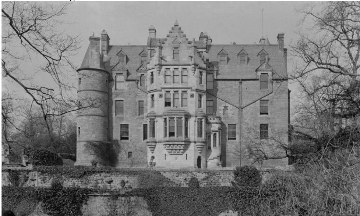
Fig. 14. North Lanarkshire, Dalzell House (vue du sud), 1859, Robert Billings, état en 1886. Photo de John Fleming/RCAHMS.
