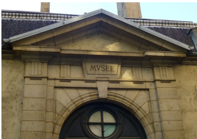
Détail de la façade de l'hôtel Lacroix-Laval, Soufflot, J.-G. 1739-1754
