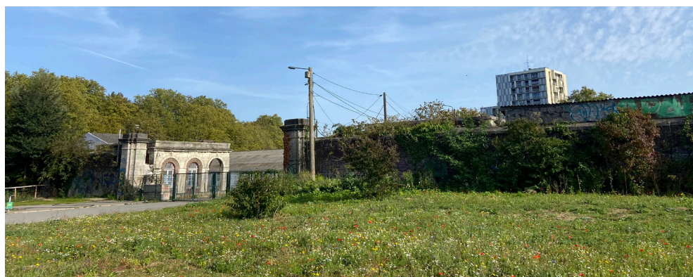
Fig-38 La porte de Dunkerque et les restes du rempart
