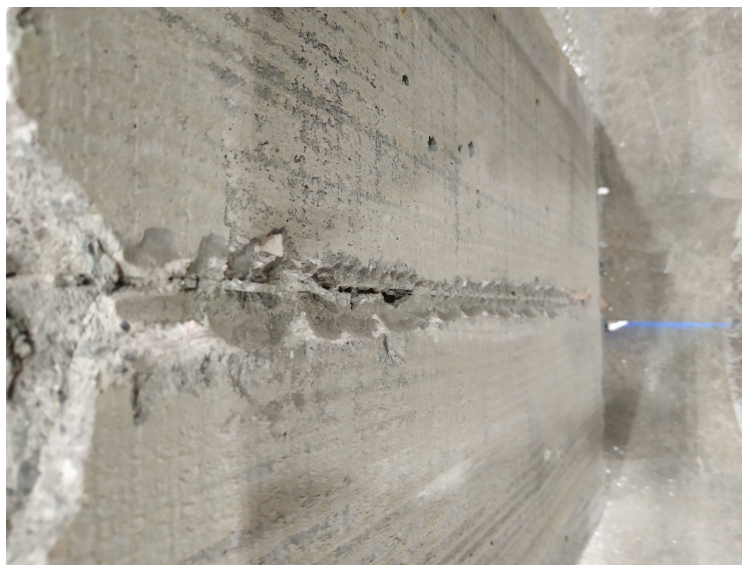
Figure 5.35 – Image de la partie de la tôle étant restée dans le béton après la rupture
