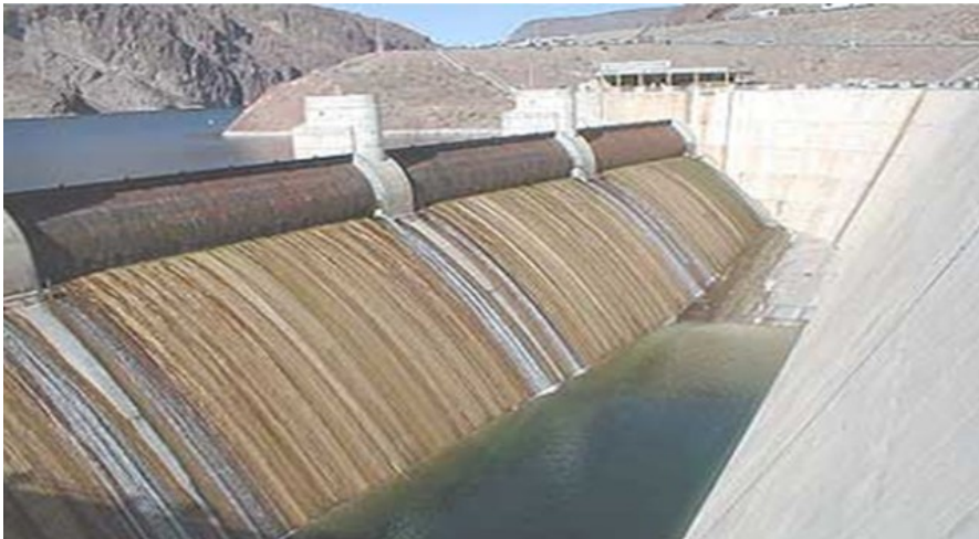
FIGURE 2 – Évacuateur de crue latéral, Hoover Dam, USA.
