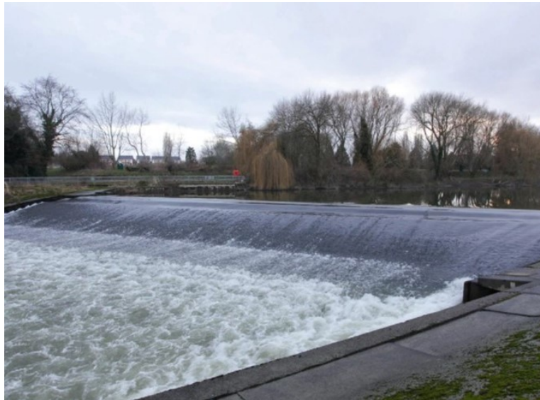
FIGURE 3 – Déversoir, Shrewsbury, Royaume-Uni.
