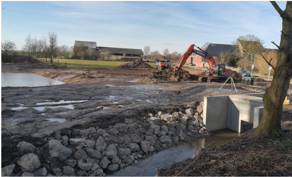
FIGURE 3.5 : Construction de la digue avec la prairie en arrière-plan[5].
