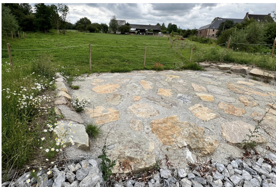
FIGURE 3.18 : Le haut de la surverse après travaux effectués en 2022.
