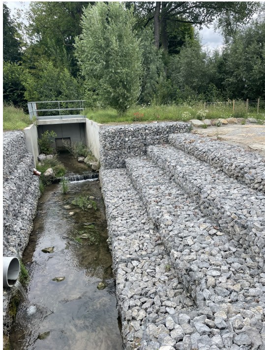
(a) Surverse après travaux effectués en 2022.
