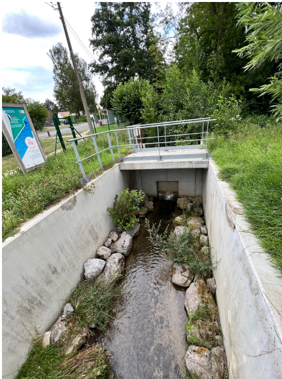
FIGURE 3.6 : Pertuis en béton côté aval. Photo prise en 2023.
