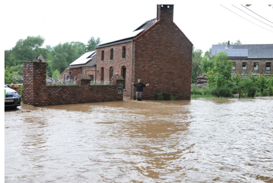
FIGURE 3.3 : Rue du Tilleul 34 lors d'inondations en juin 2012.
