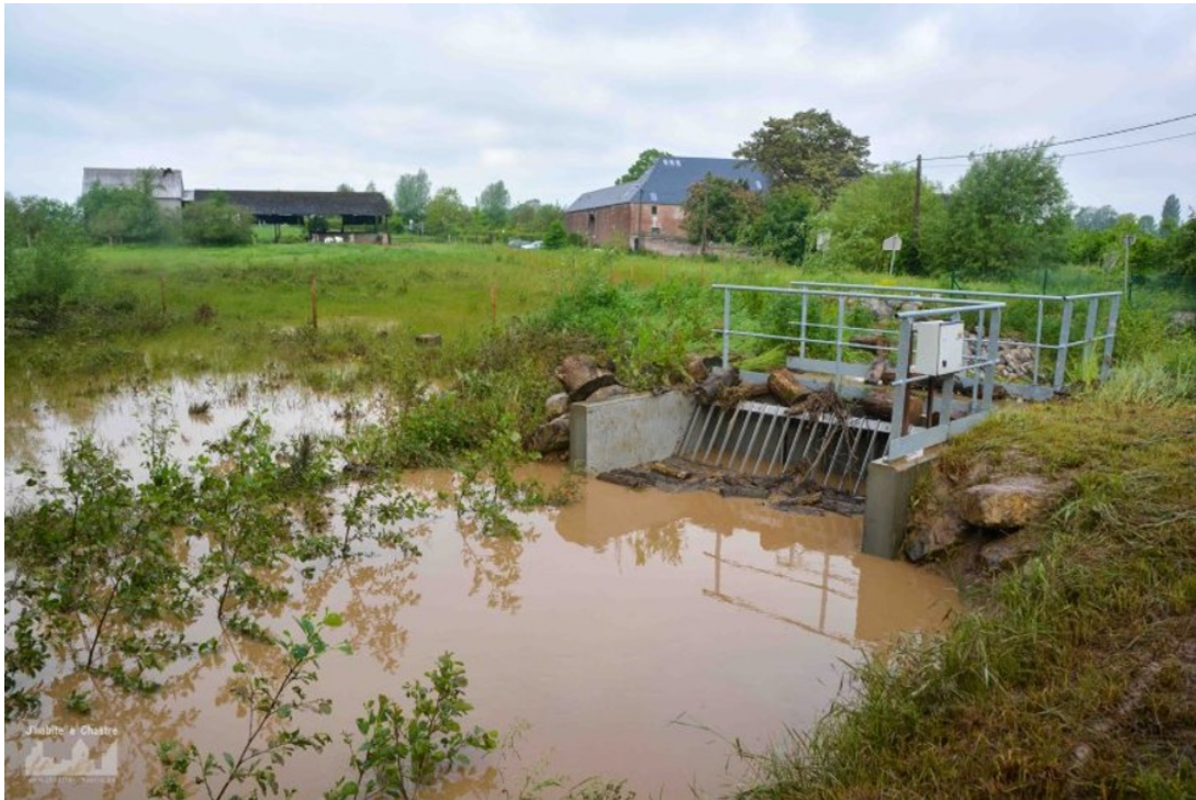
FIGURE 3.15 : Etat à l'amont de la vanne au lendemain d'une inondation[24].
