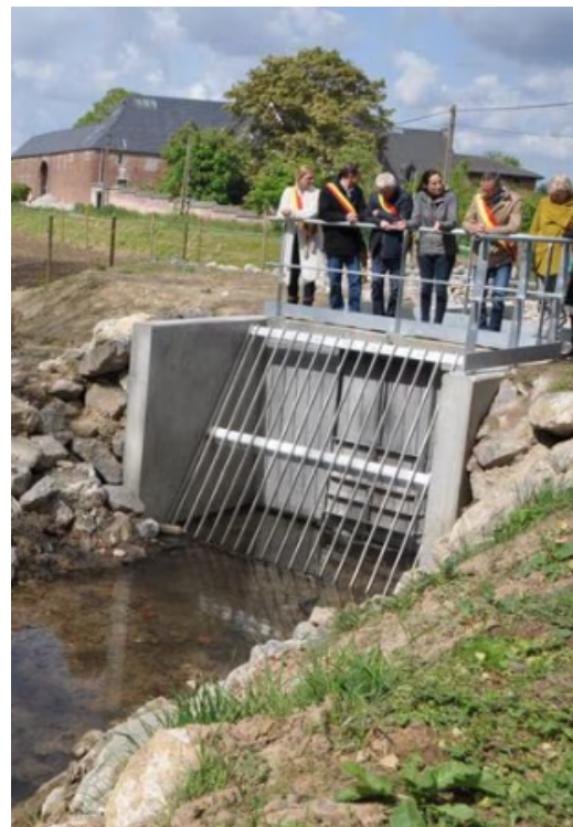
FIGURE 3.7 : Pertuis en béton côté amont avec la vanne[35].
