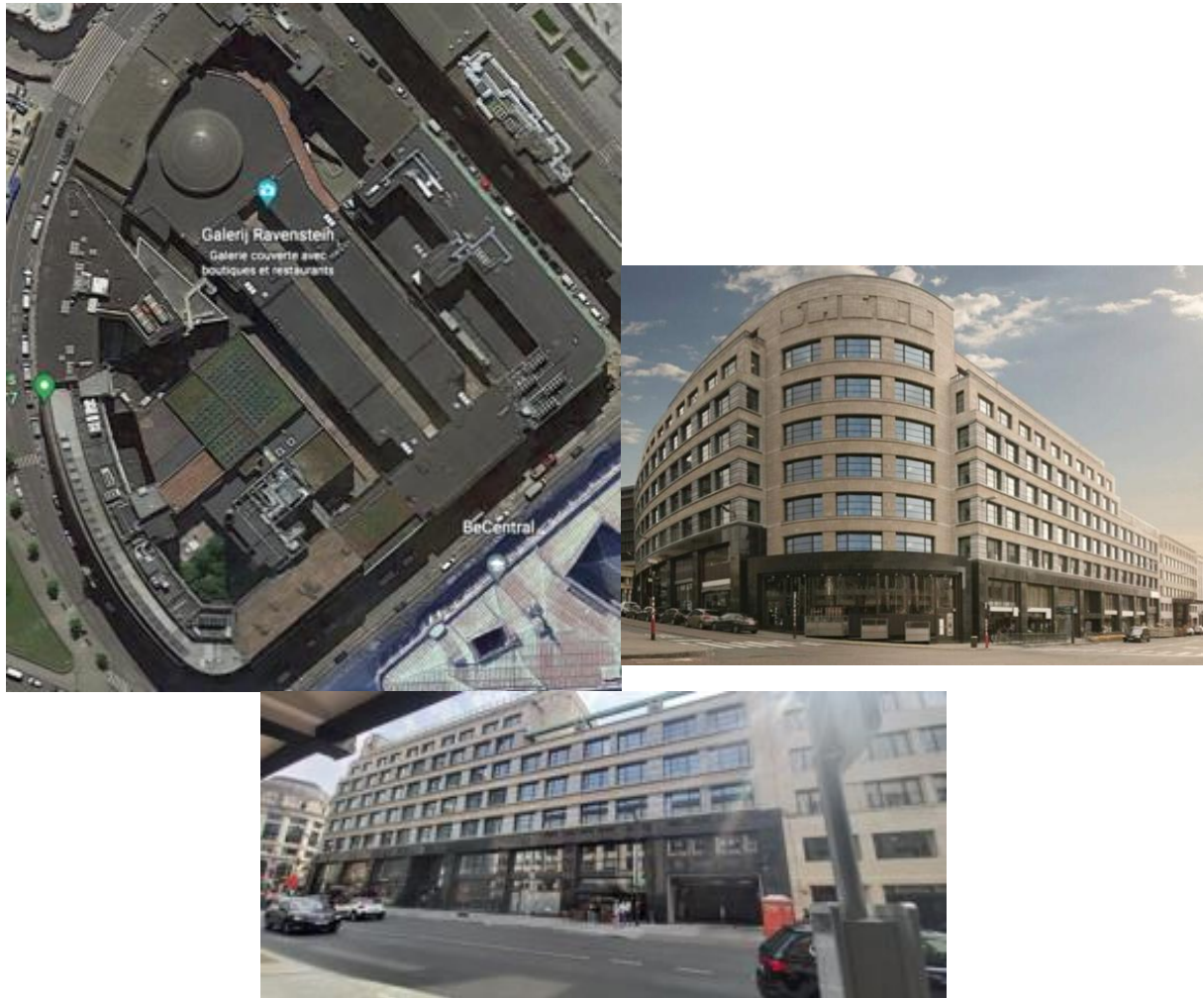
Figure 8: Vues partielles du Central, image satellitaire à gauche et images des façades des entrées principale (en dessous) et secondaire (au-dessus).
