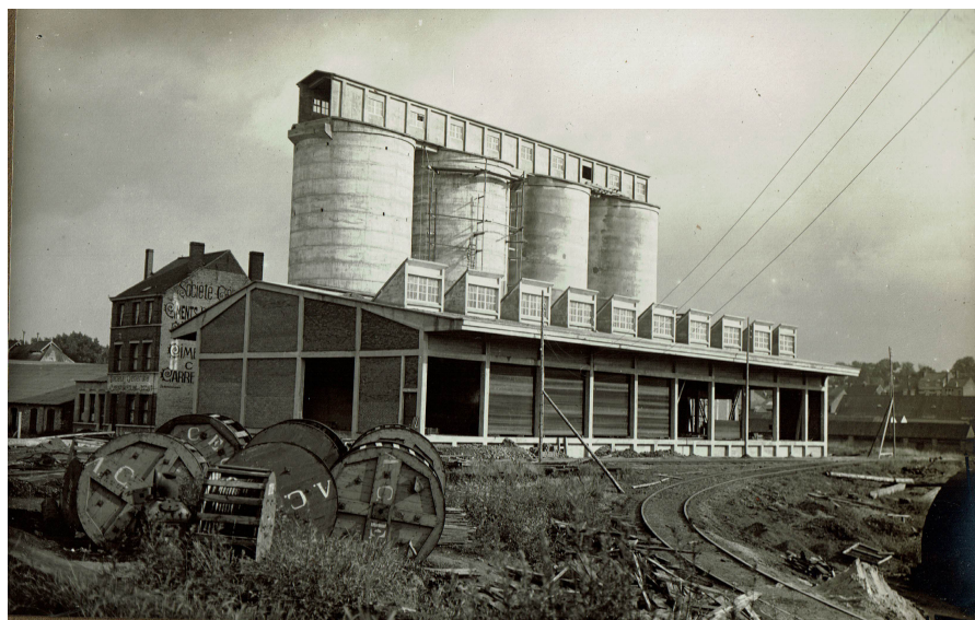
Fig. 6 Construction des quatre premiers silos, juin 1925
