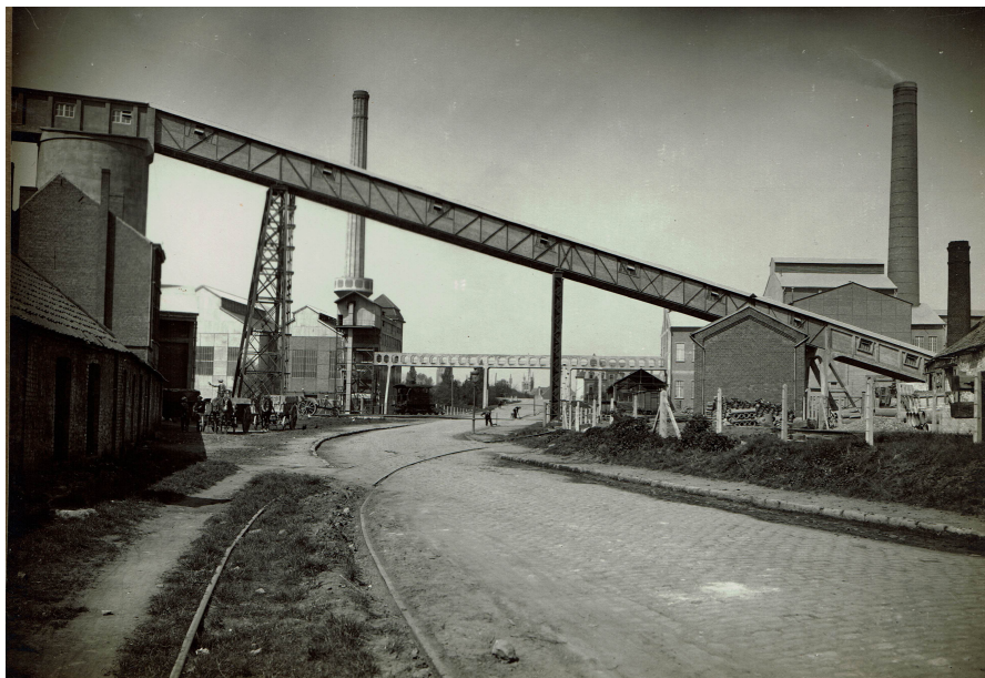
Fig. 3 Bande transporteuse passant au-dessus de la Rue de Lys, avril 1926
