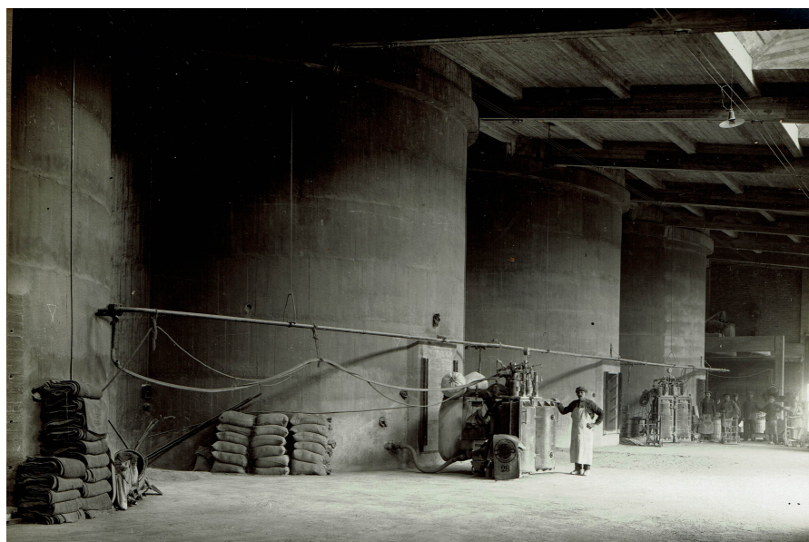
Fig. 13 Vue intérieure de la première partie de la halle, avril 1926
