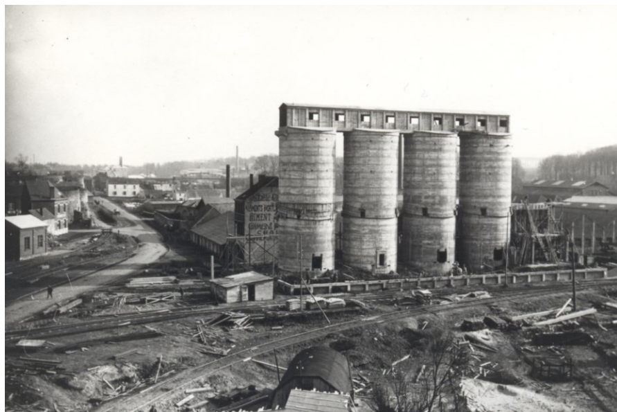
Fig. 5 Construction des quatre premiers silos, 1925
