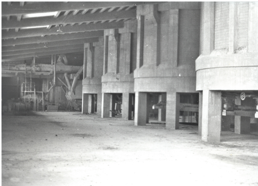
Fig. 14 Vue intérieure de la seconde partie de la halle, après 1943
