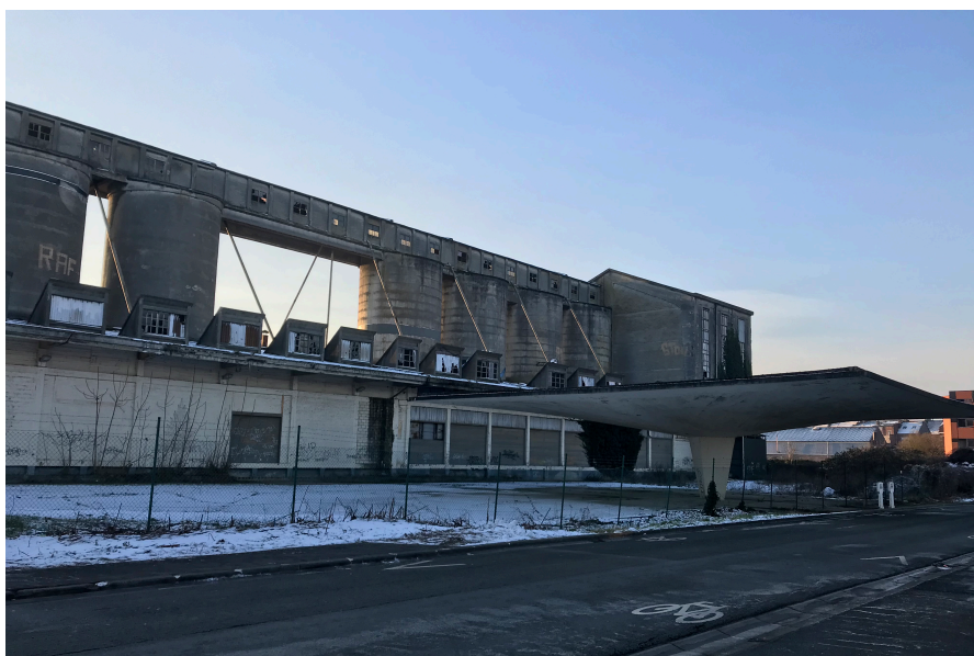
Fig. 19 Vue depuis la rue, Allée des Princes d'Allain, 2021
