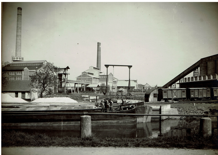
Fig. 4 Ampleur de la cimenterie Dapsens, avril 1926
