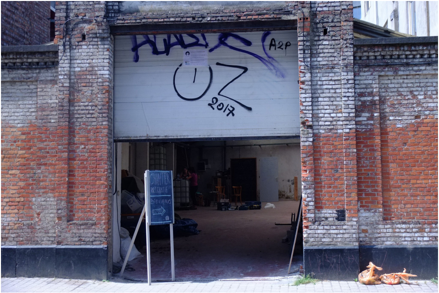
Fig. 14 Entrée de la Serre, un chantier qui s'ouvre sur le quartier, 2017
