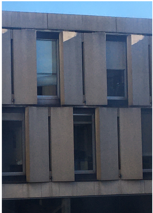
Figure 41 : Extrait de façade du socle, vue depuis le patio (les boucliers de béton), Zachary ADJOU.
