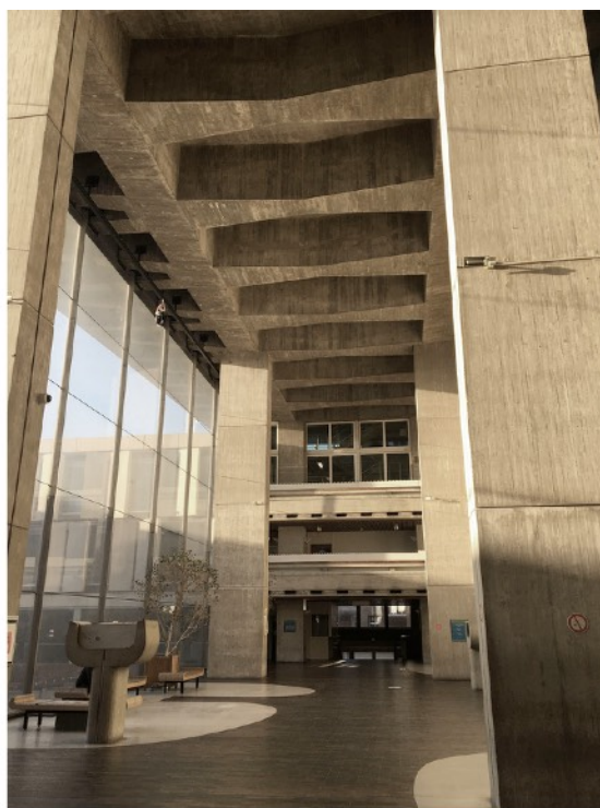
Figure 44 : Réseau de poutres soutenant la tour. vue depuis la salle des pas perdus, Zachary ADJOU.
