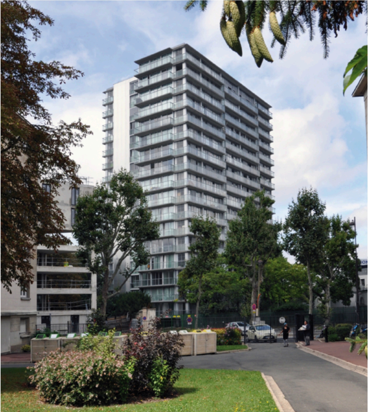
Figure 25 : La tour après l'intervention. lacatovassal.com
