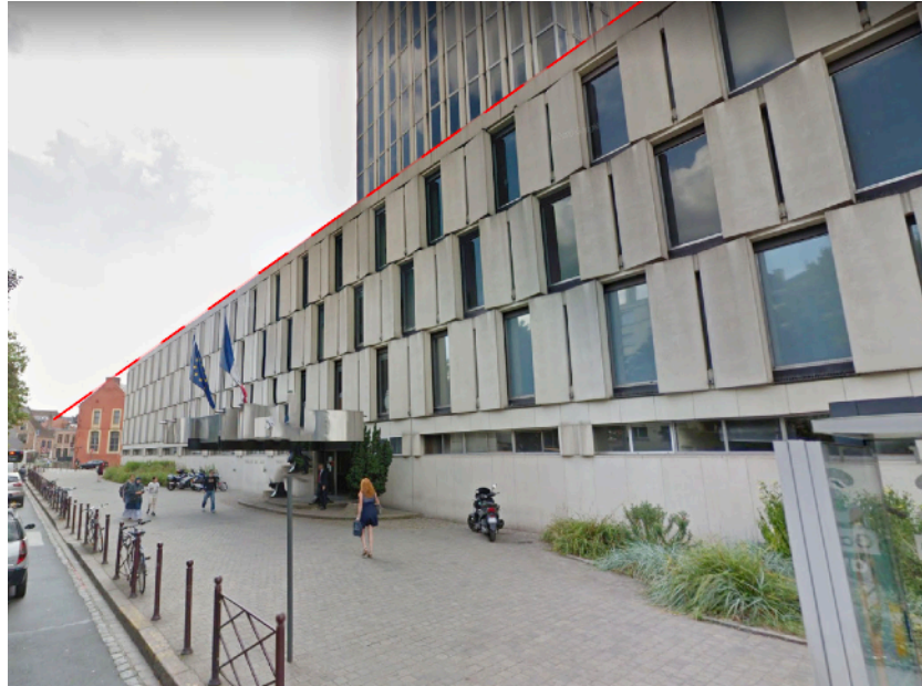
Figure 32 : L'acrotère du socle parfaitement aligné à la façade du Musée de l'Hospice Comtesse GoogleStreetView.com
