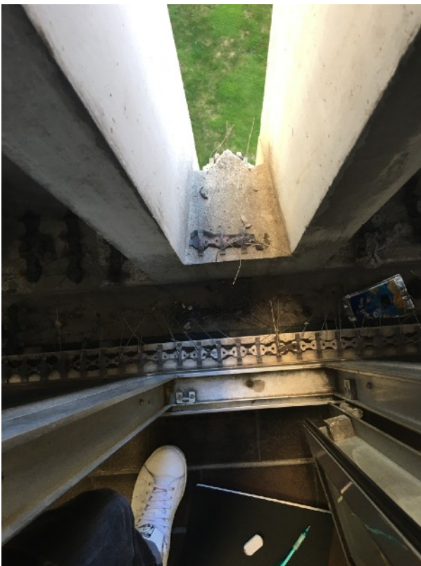
Figure 38 : Les étroits ouvrants disposés derrière les modules de béton, Zachary ADJOU.
