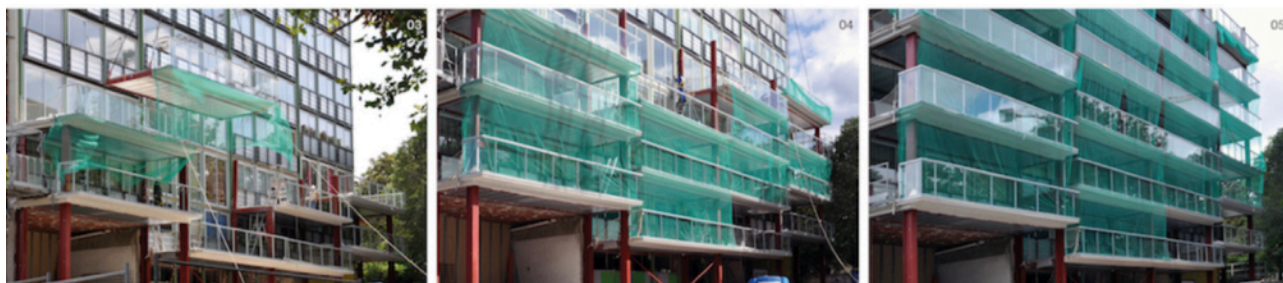
Figure 21 : La structure en cours d'assemblage. lacatonvassal.com
