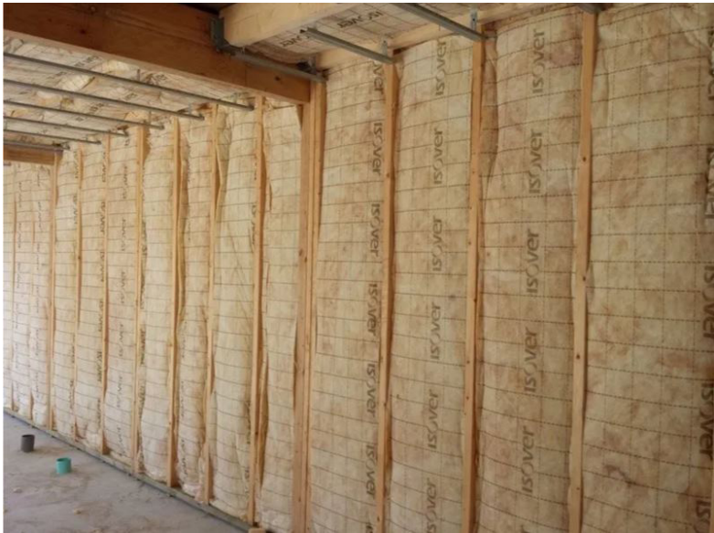
ill 2.40: Isolation dans l'épaisseur de la structure.
