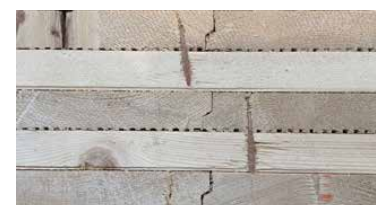
ill 2.73: Photos d'une paroi en CLT cloué avec des clous de bois.
