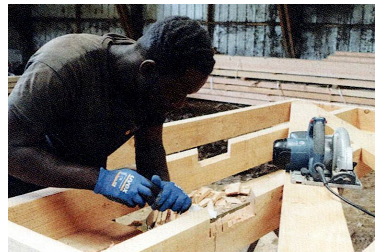
ill 2.67: Utilisation de techniques artisanales pour l'assemblage des écharpes de contreventement.
