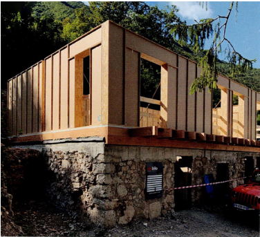
ill 2.37: Système de caisson contenant l'isolant.
