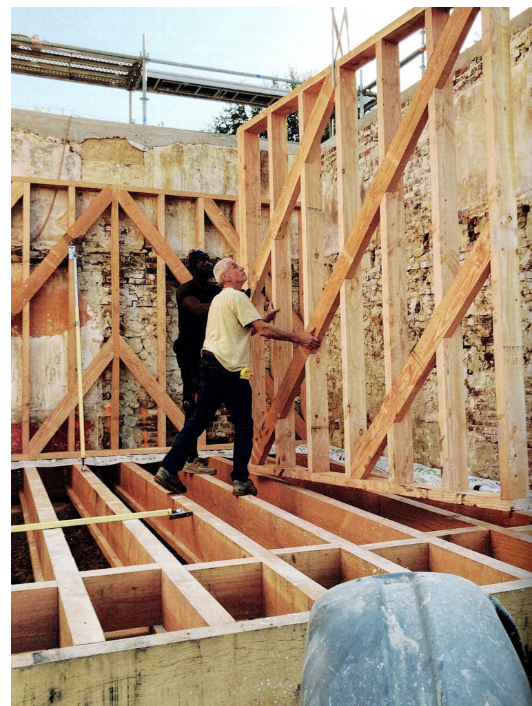
ill 2.68: Mise en oeuvre des pans d'ossature bois du chantier pédagogique du Costil.
