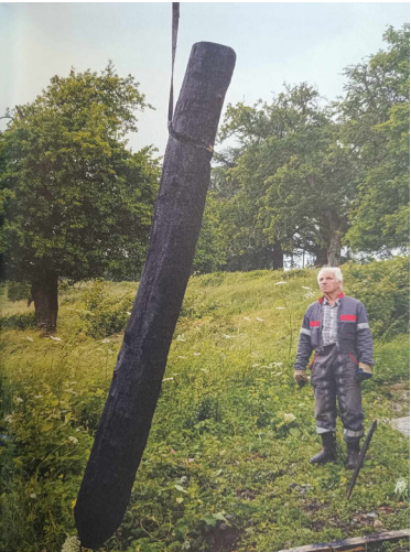
ill 4.32: Mise en sol d'un pieu de fondation en robinier.
