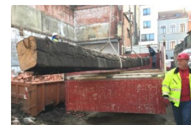
ill 2.29: Démontage des éléments en bois.
