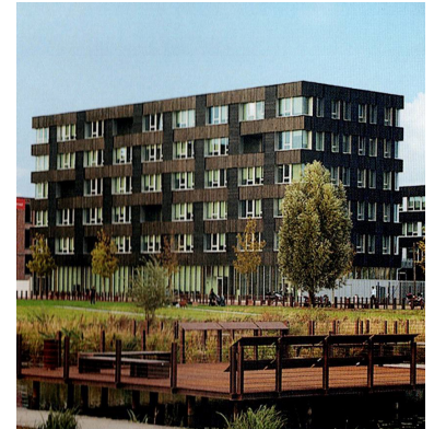
Ill 4.34: Exemple d'un bardage en bois brûlé.
