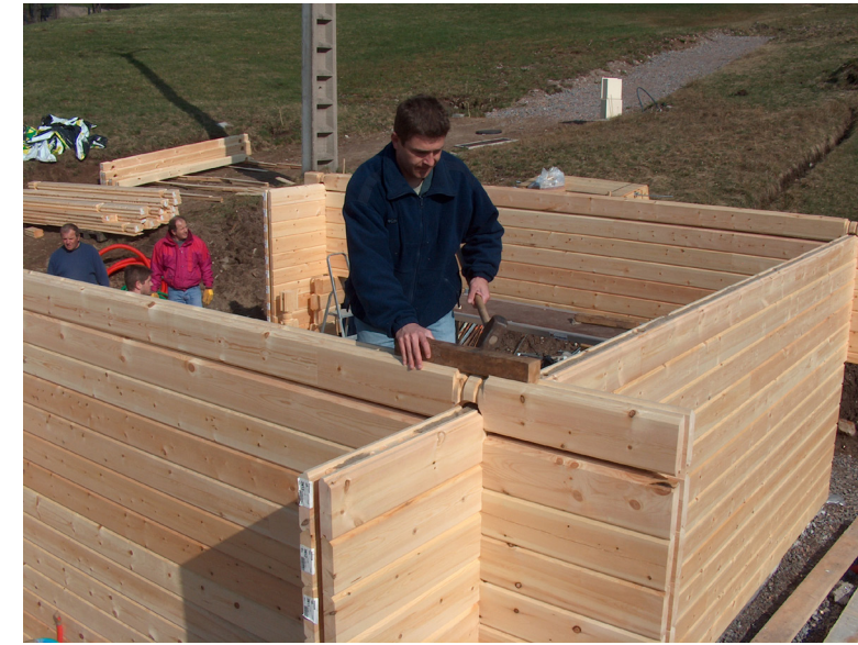
ill 2.44: Photo de mise en oeuvre d'un système de madrier à la main.
