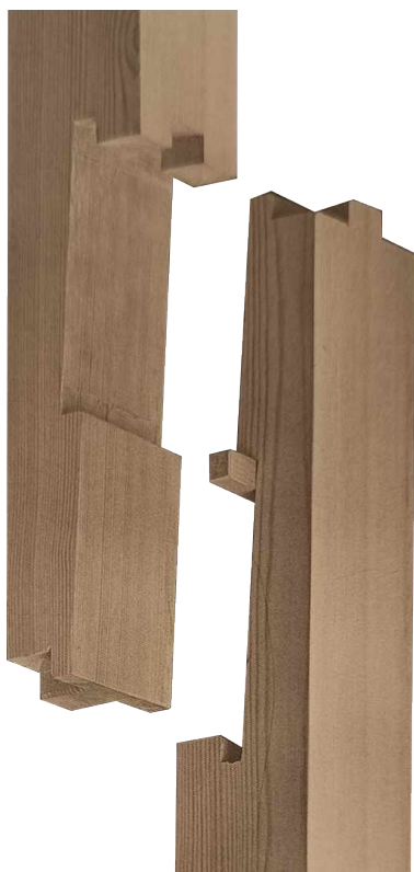
ill 4.26: Photo de l'assemblage du trait de jupiter avec tenon en «T».
