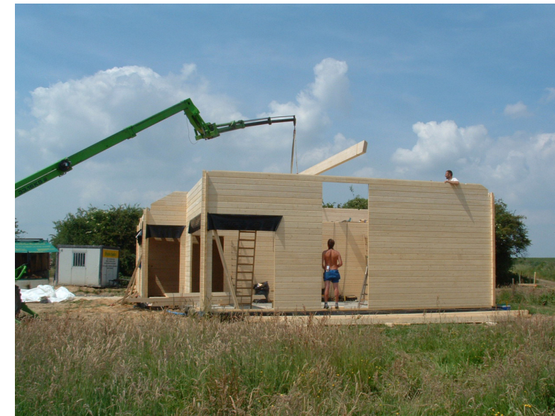
ill 2.45: Photo du montage d'une maison en madrier au jour 3.
