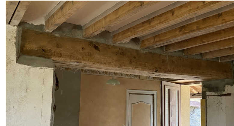
ill 2.59: Exemple d'une liaison bois-maçonnerie.
