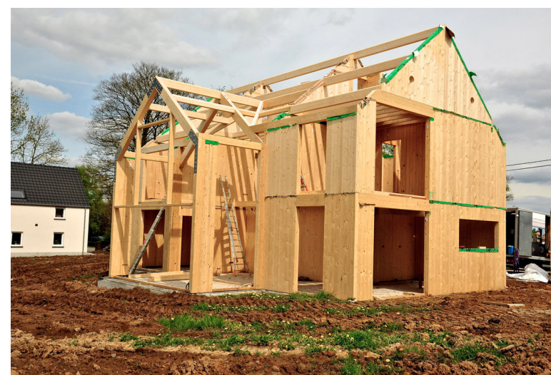
ill 2.73: Photos d'une paroi en CLT cloué avec des clous de bois.
