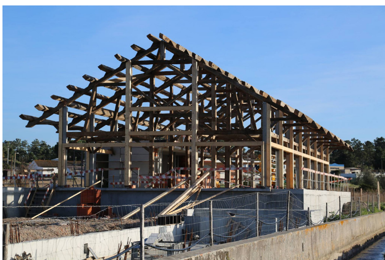
ill 2.71: Mixité des bois neufs et de réemploi en structure.
