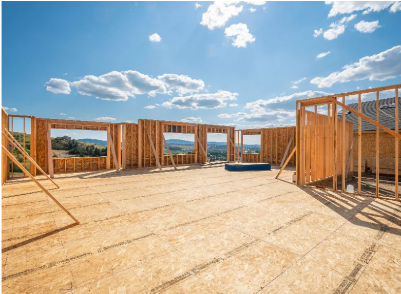
ill 2.39: Contreventement des parois par panneaux OSB.
