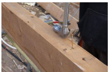
ill 2.30: Retrait des éléments métalliques.
