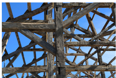
ill 2.69: Zoom sur les assemblages traditionnels utilisés dans un projet Hôtel, Spa, Restaurant à Comporta.
