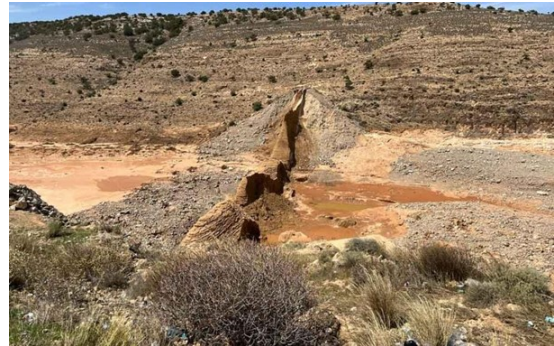
FIGURE 6: Barrage Mansour (75m) après la rupture.[4]
