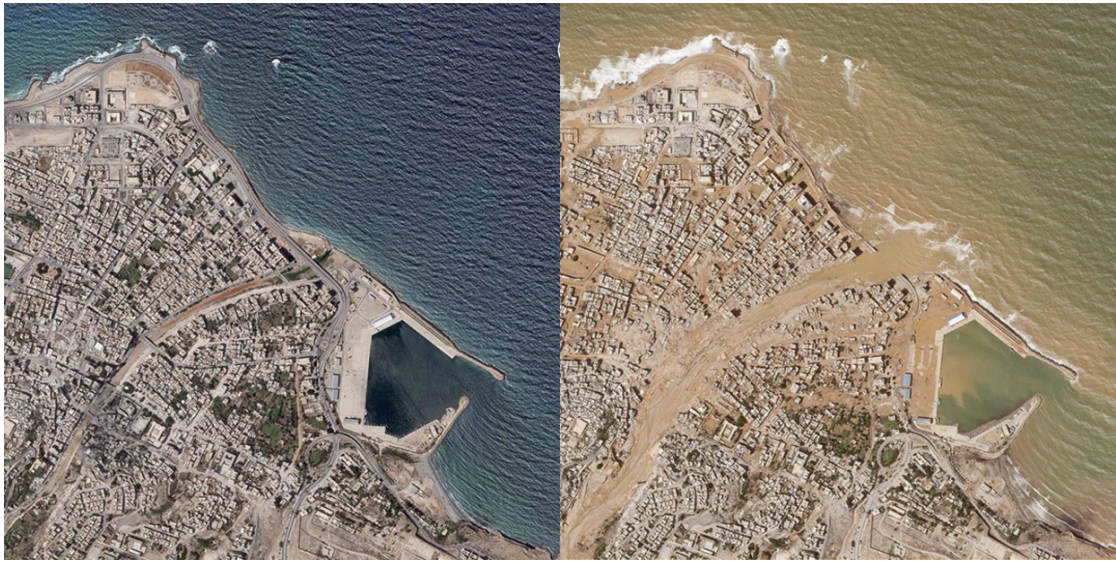
FIGURE 4: Avant/Après l'inondation suite aux ruptures de barrages à Derna (Libye, juillet 2023).[50]
