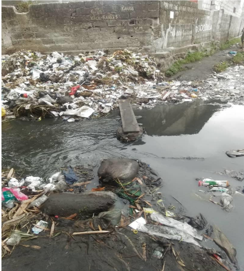
Pont Avenue Lobo à Ngaba(à la frontière avec la commune de Lemba)
