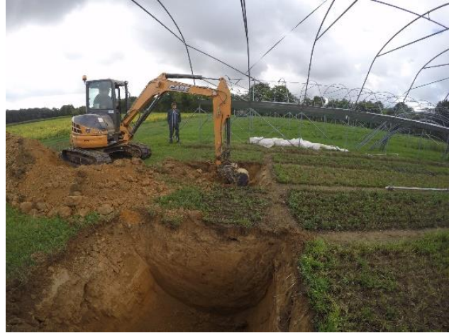
Figure 6: Mise en place des fosses avec la pelle mécanique
