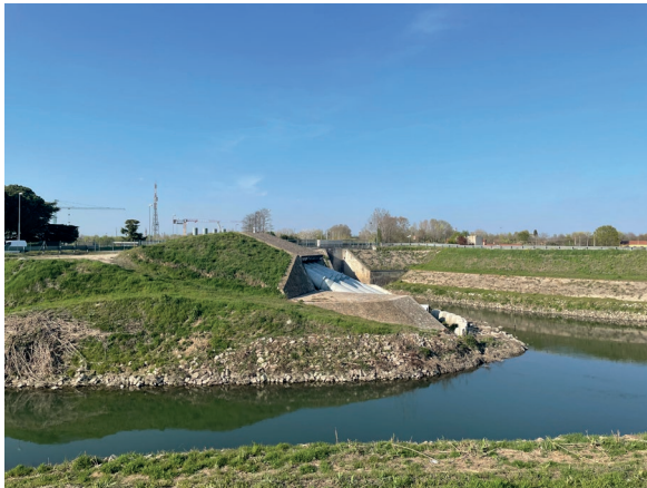
Fig.27 Tuyaux de déversement dans un canal, province de Padoue
