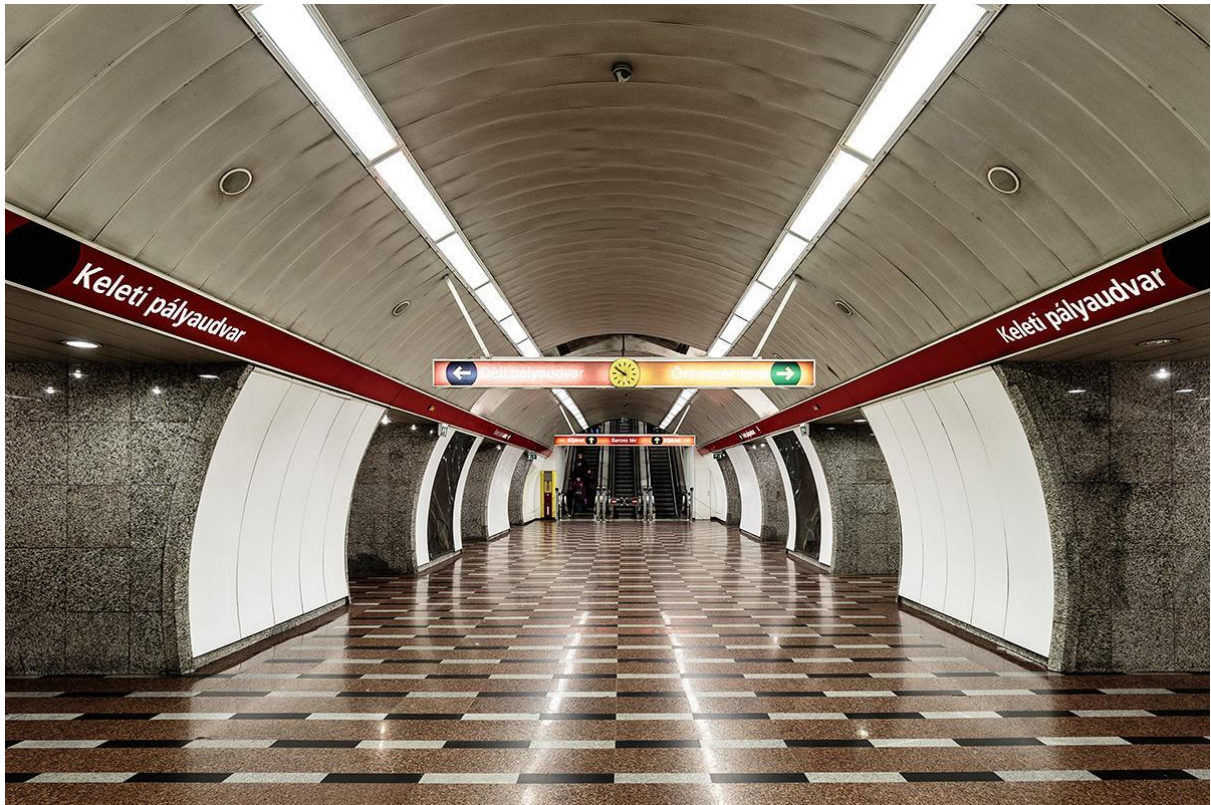
Fig. 159. Budapest, station Keleti pályaudvar, vue intérieure de la station, hall central, s.d.
