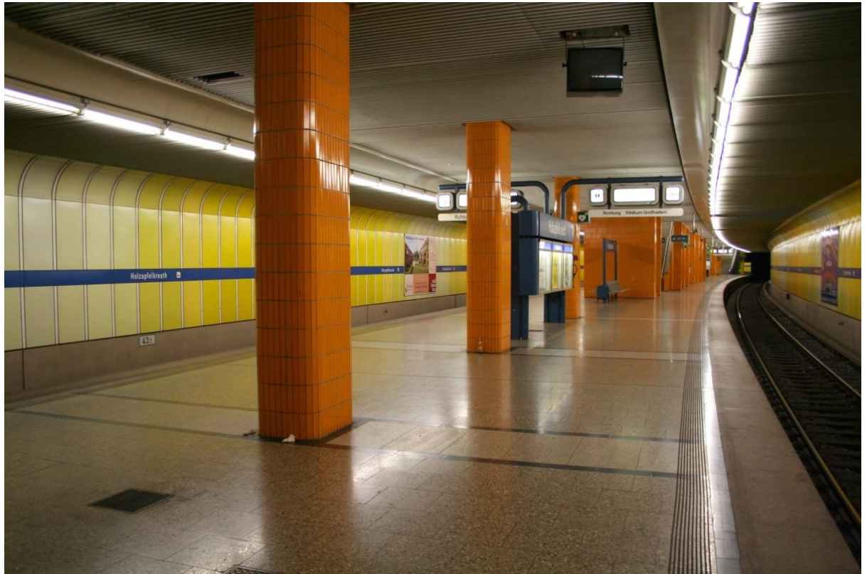
Fig. 161. Munich, station Holzapfelkreuth, vue intérieure de la station, quai central, 2007.
