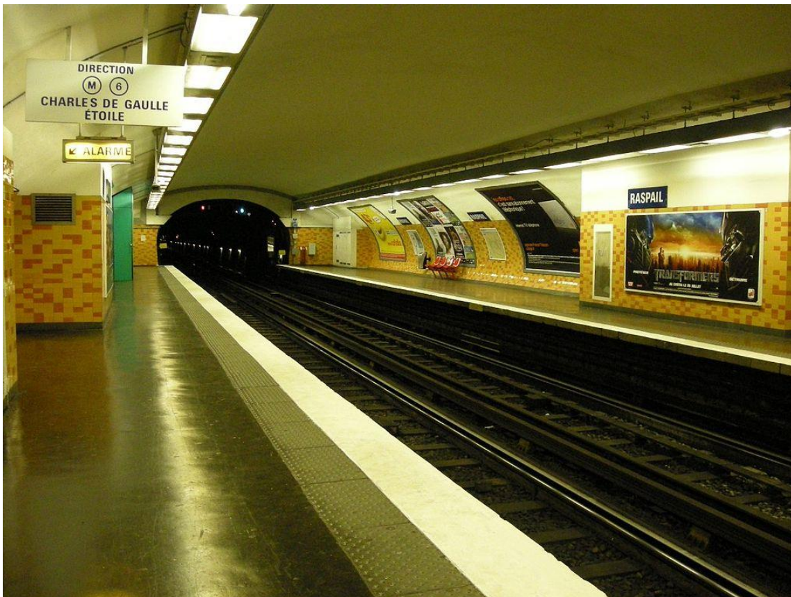
Fig. 44. Paris, station Raspail, vue intérieure de la station de la ligne 6 avant la rénovation, 2007.
