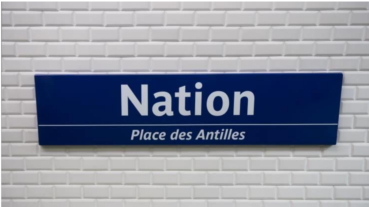
Fig. 17. Paris, station Nation, vue intérieure de la station, détail du recouvrement des parois à l'aide de carreaux biseautés blancs, s.d.
