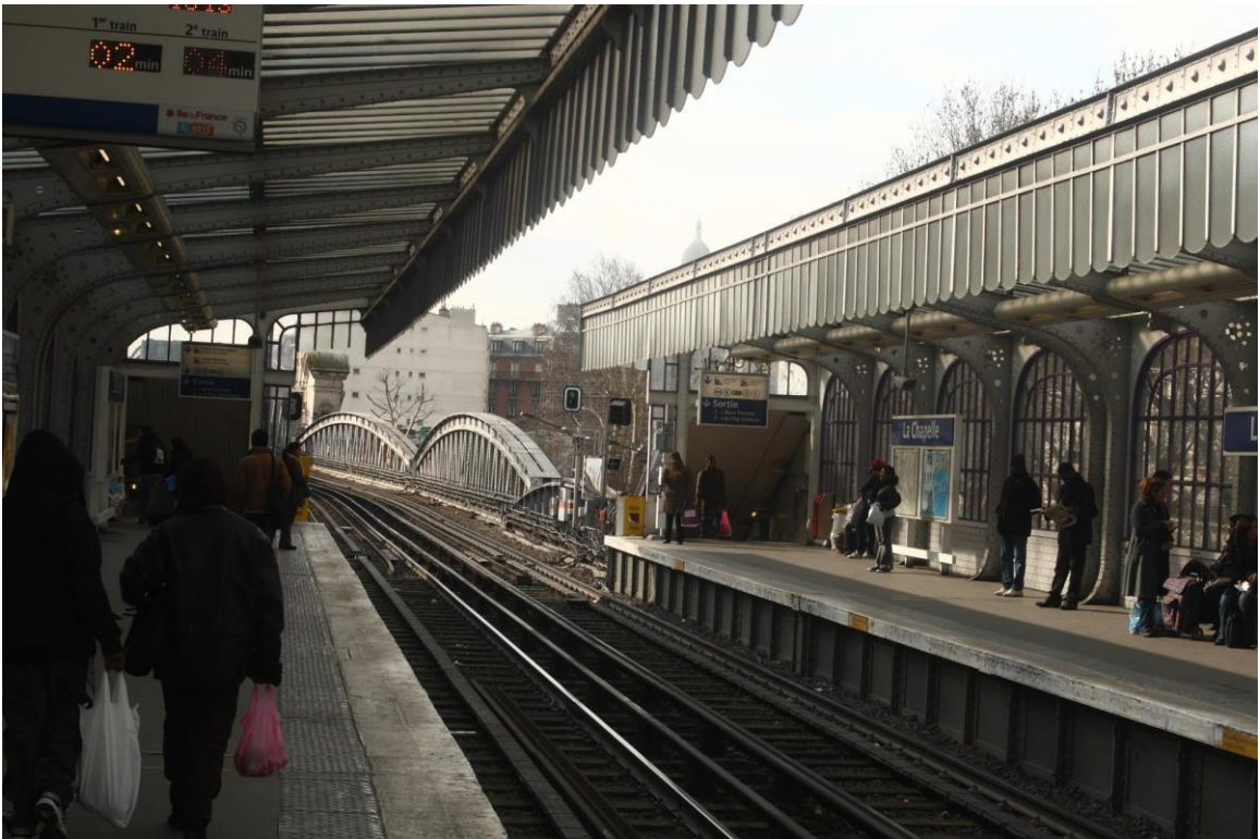
Fig. 22. Paris, station La Chapelle, aperçu des quais de la station aérienne, 2010.
