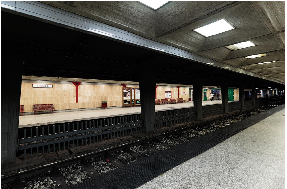
Fig. 157. Budapest, station Mexikói út, vue intérieure de la station, aperçu des voies, s.d.
