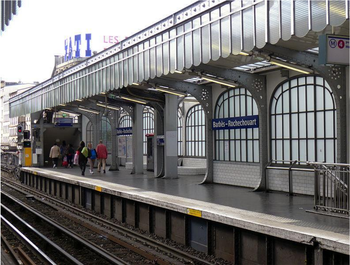
Fig. 21. Paris, station Barbès-Rochechouart, aperçu des quais de la station aérienne, 2015.
