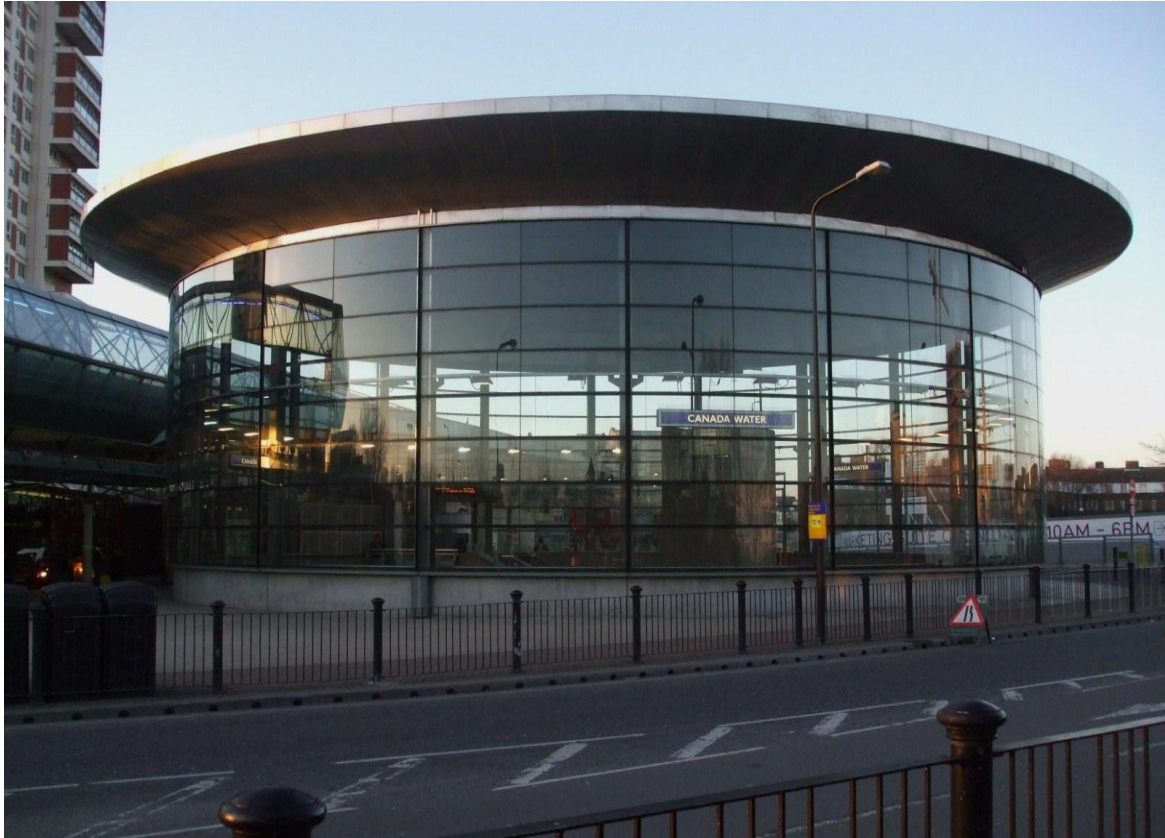
Fig. 144. Buro Happold, Londres, station Canada Water, façade de l'édifice d'entrée, 2009.
