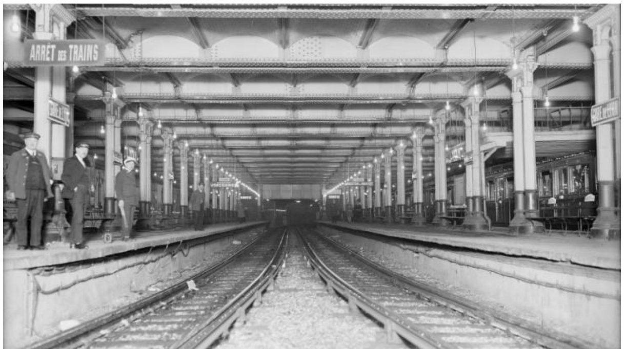
Fig. 15. Paris, station Gare de Lyon, vue intérieure de la station depuis les voies, s.d.
