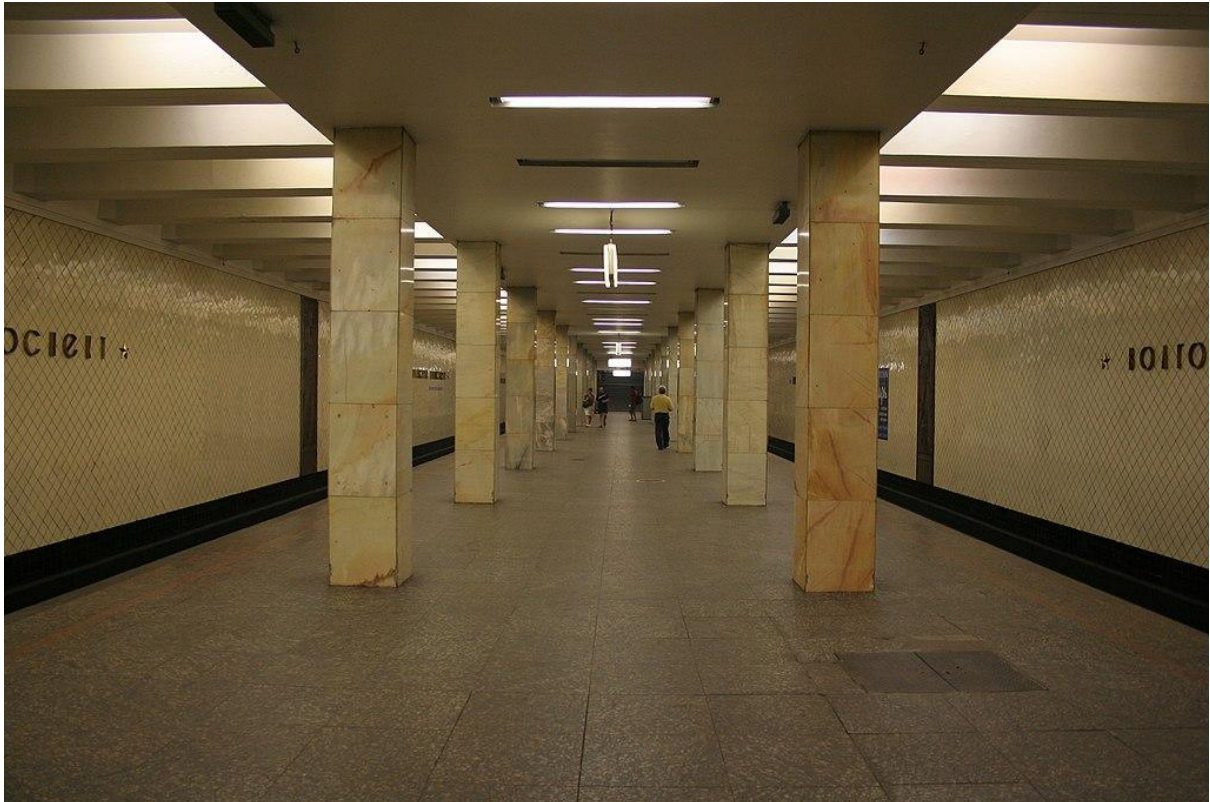
Fig. 88. V. G. Polikarpova et A. A. Marova, Moscou, station Volgogradski prospekt, vue intérieure de la station, hall central, 2010.
