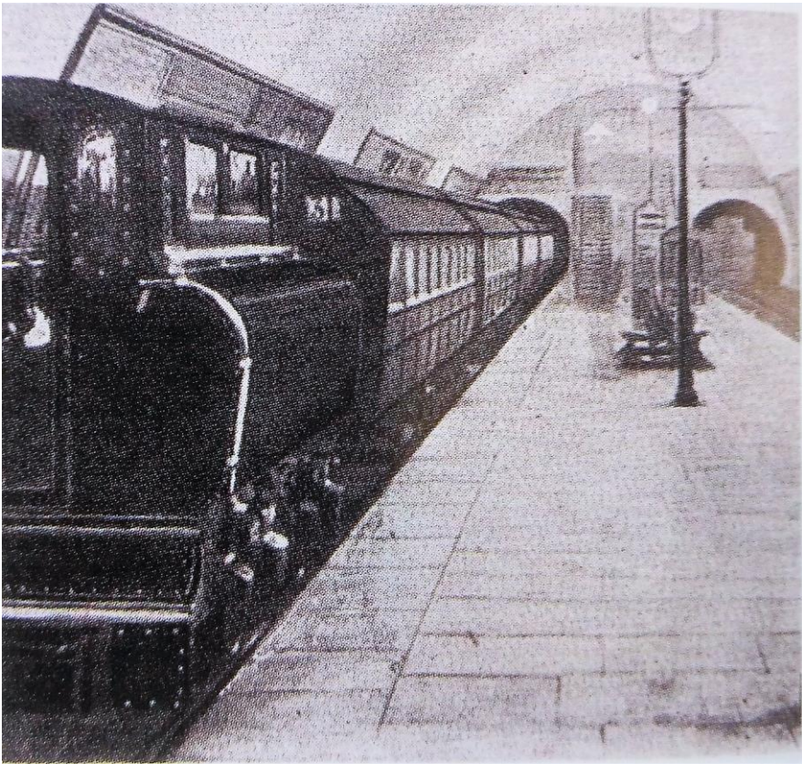
Fig. 114. Ch. Grey Mott, Londres, station du City and South London Railway, vue intérieure de la station, quai central, s.d.
