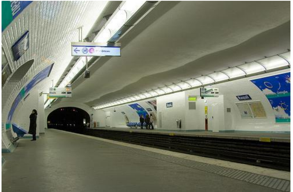
Fig. 45. Paris, station Raspaill, vue intérieure de la station de la ligne 6 après la rénovation, 2008.
