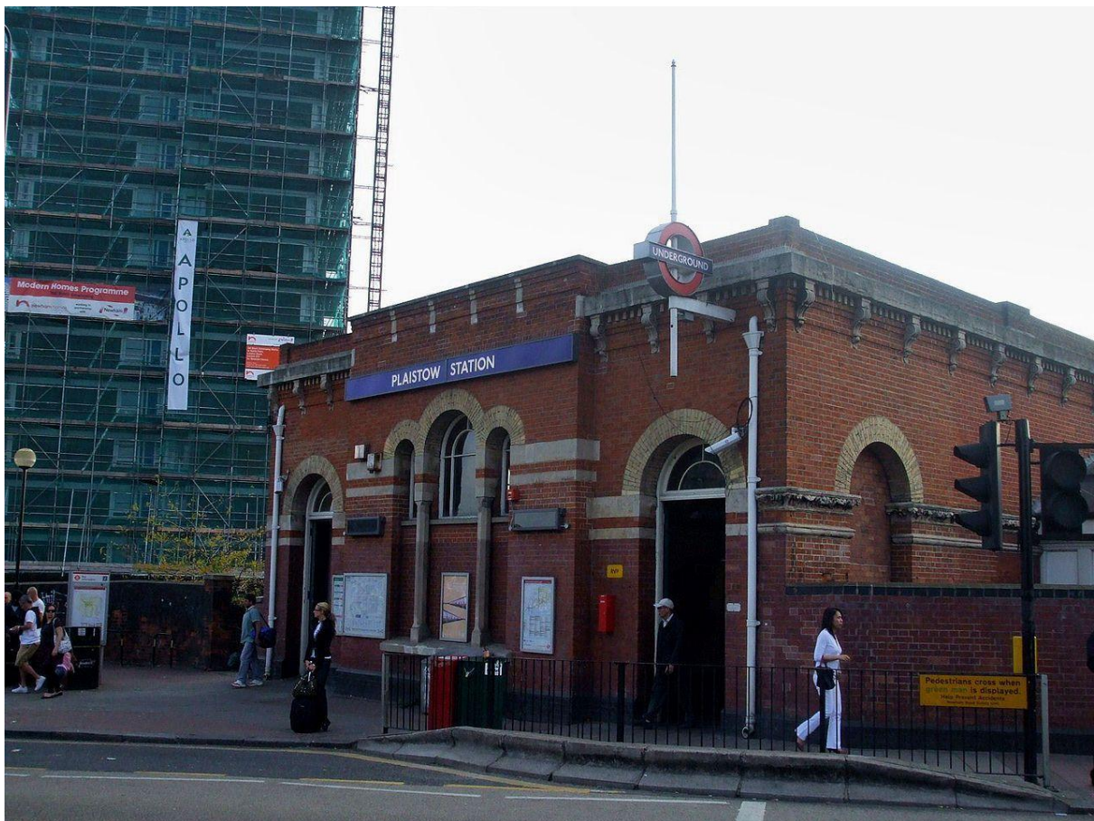
Fig. 122. Londres, station Plaistow, façade de la station, 2008.
