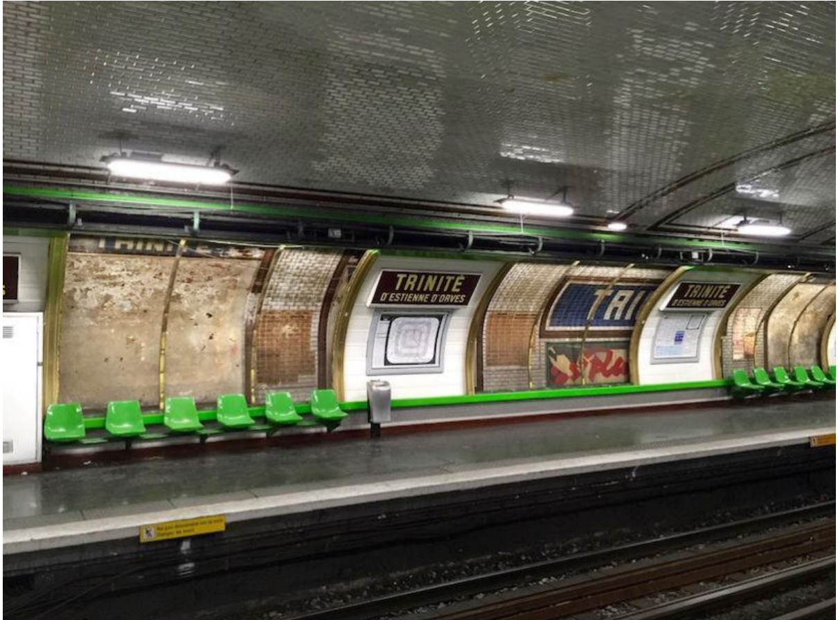
Fig. 7. Paris, station Trinité, cliché de Maryan Lukaszczyk, vue intérieure de la station, aperçu des travaux de décarrossage des parois latérales des quais, 2016.
