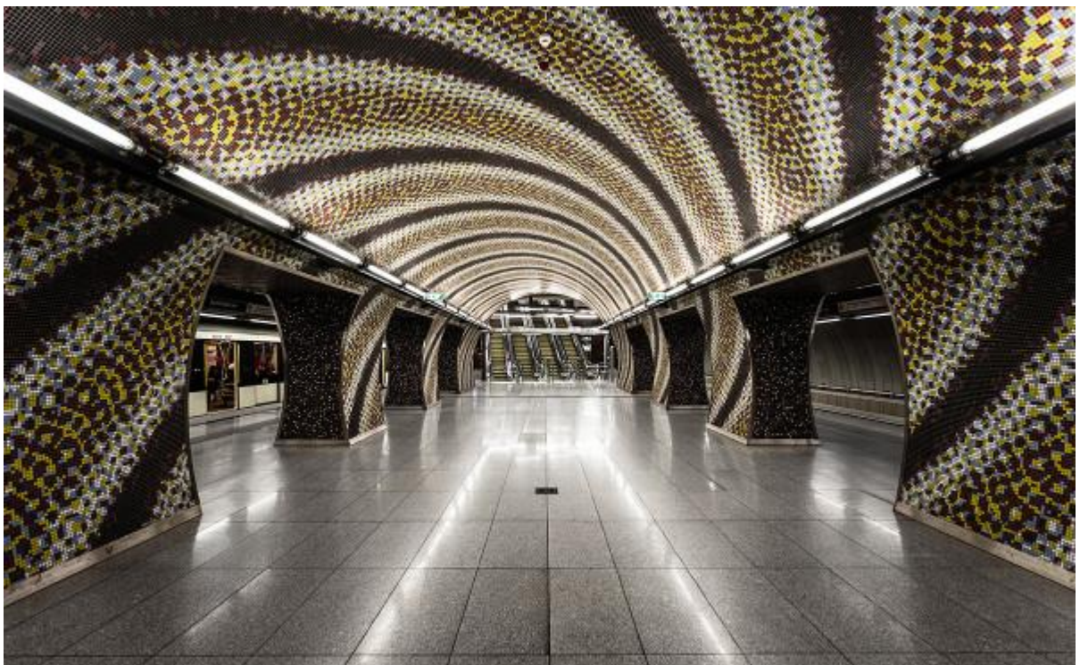
Fig. 164. Budapest, station Szent Gellért tér, vue intérieure de la station, hall central, s.d.
