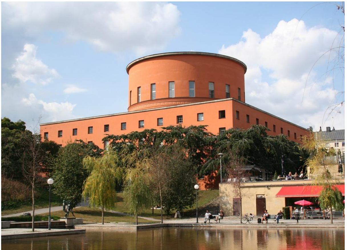
Fig. 128. E. G. Asplund, Stockholm, bibliothèque publique, façade de l'édifice, s.d.
