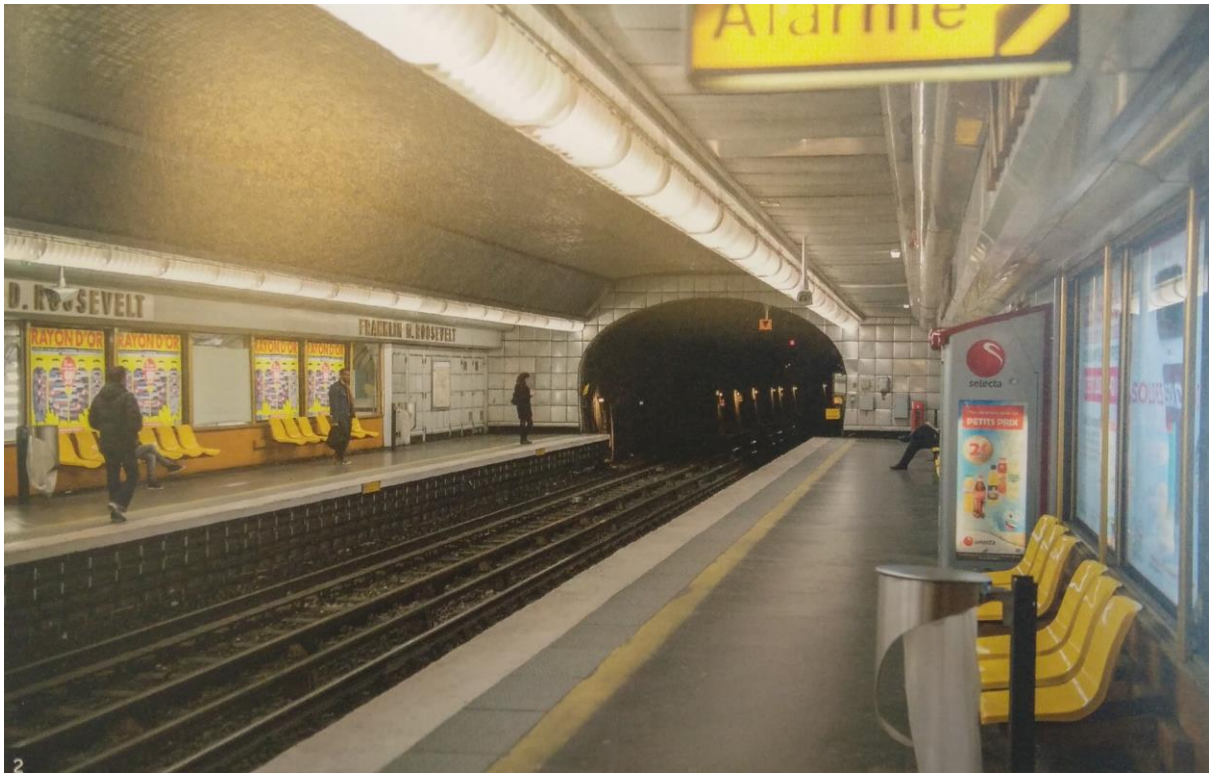
Fig. 43. Paris, station Franklin D. Roosevelt, vue intérieure de la station et des quais, s.d.
