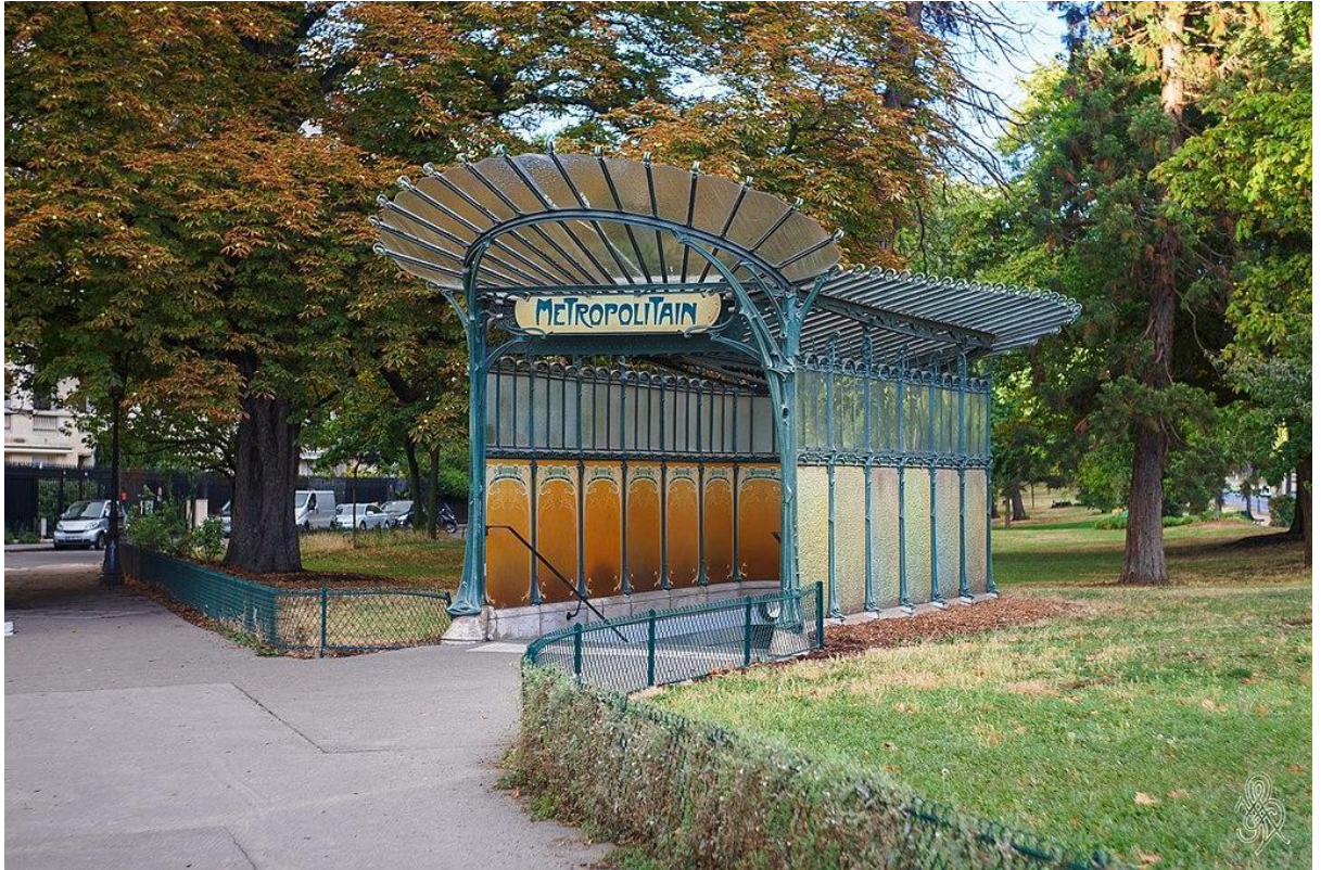
Fig. 18. Hector Guimard, Paris, station Porte Dauphine, édicule d'entrée de la station de métro, 2017.
