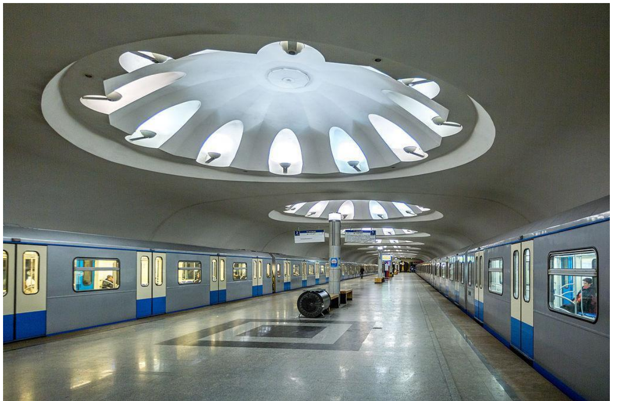
Fig. 82. A. Yu. Orlov et A. V. Nekrasov, Moscou, station Annino, vue intérieure de la station, hall central, 2015.
