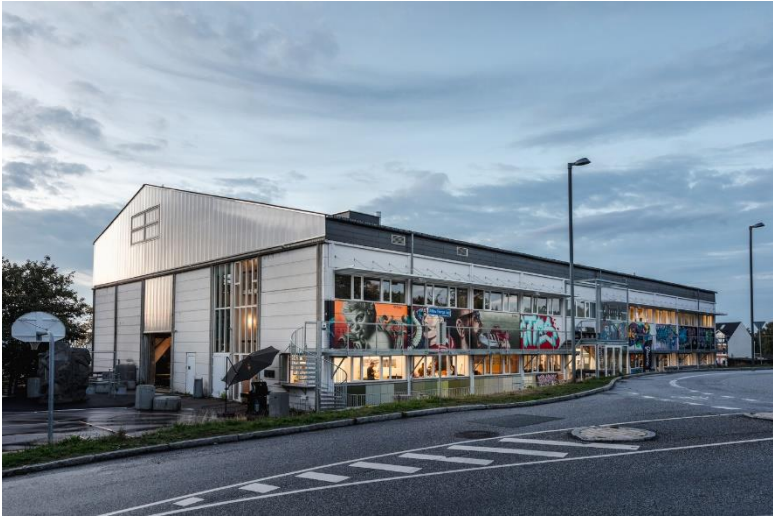
Fig. 19 : Photo extérieure de la salle omnisport « Jeu Streetmekka » (AJA-ARCHITECTS, 2018)
