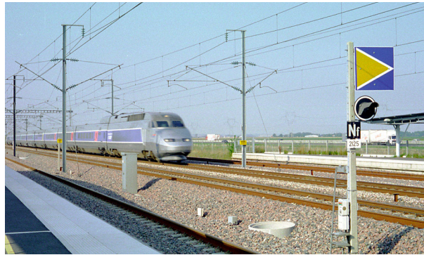
Figure 7 Système de signalisation ERTMS
