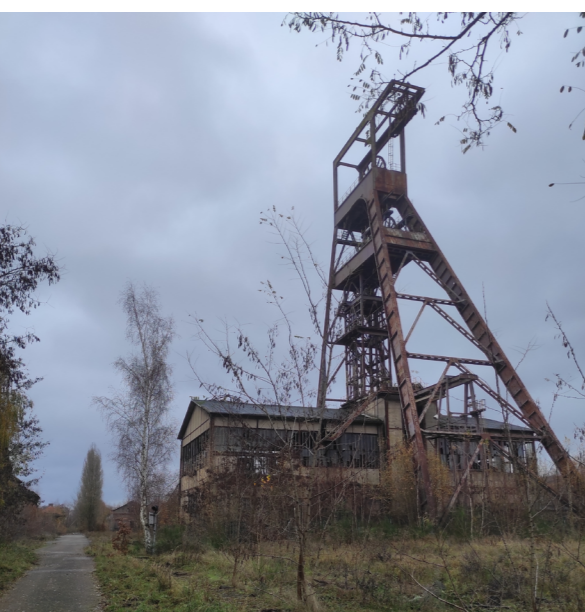
Photographie personnelle Chevalement Puits Simon II Carreau Simon
