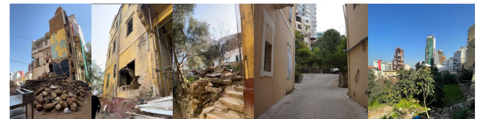
Lot 710 cage d’escalier uniquement conservé.
