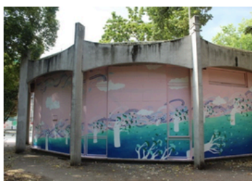
Ancien Office du Tourisme voué à la démolition (Square Léopold, Namur / août 2020) Crédits : Estelle Delbart
