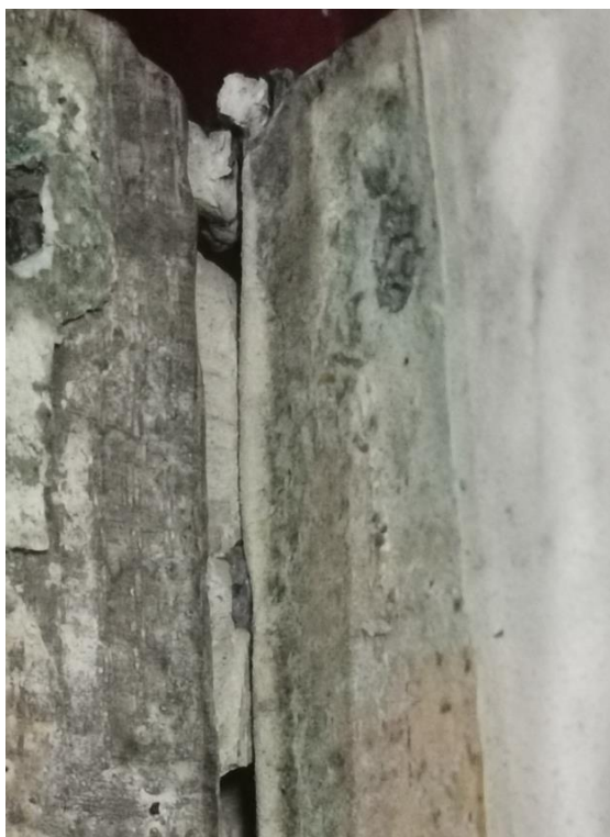
17: Ms. n°81, passage du contrefort derrière les cahier et l'ais (vue intérieure)
