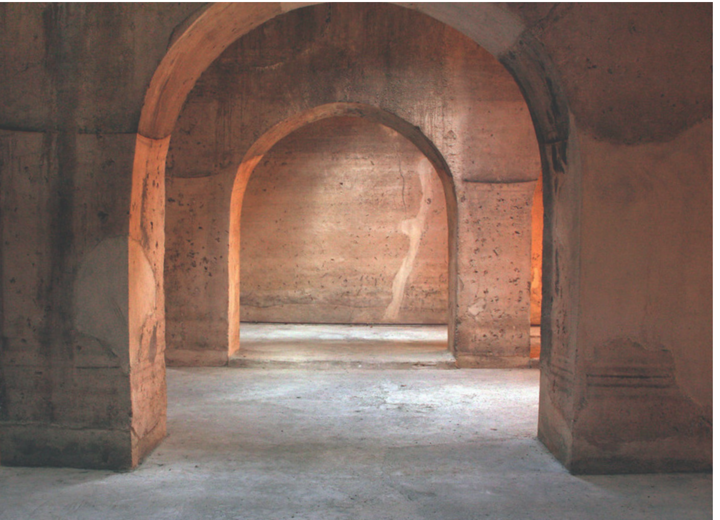
24. Photographie de la réserve d'eau, Aljibe del Rey.
