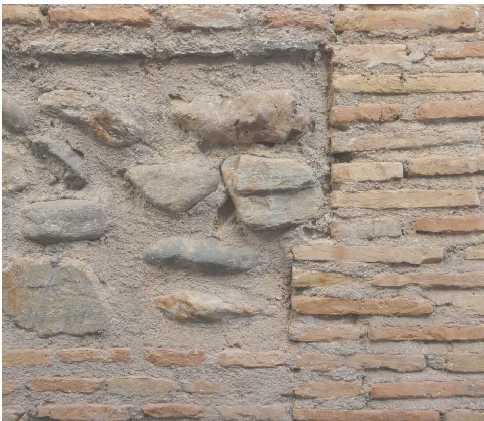
9. Photographie d'une texture d'un mur mixte en briques et pierres royales.
