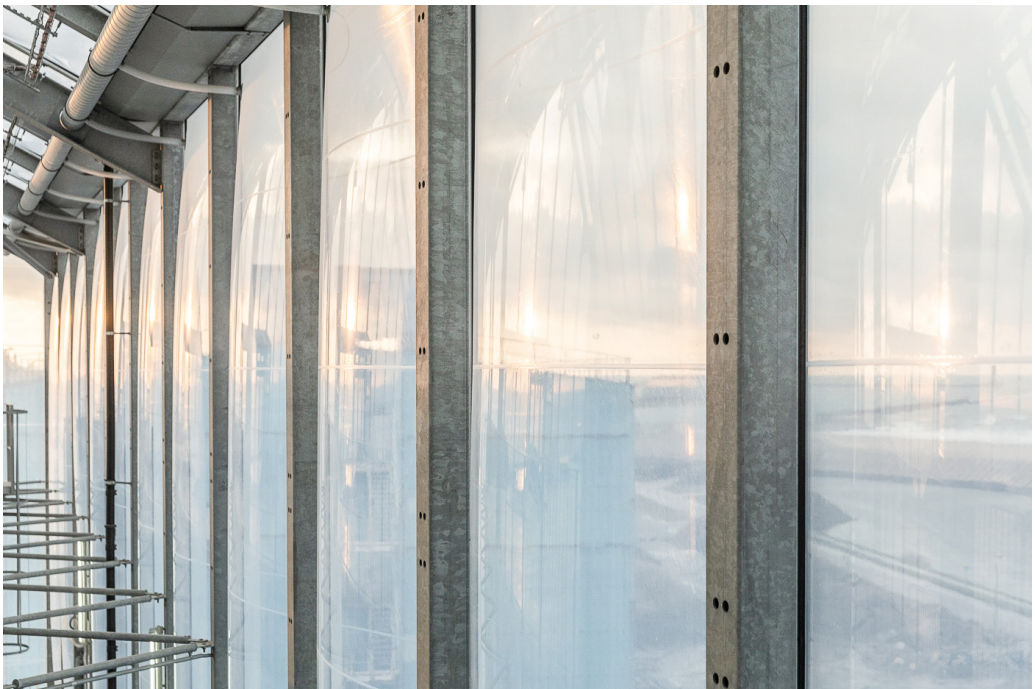
Fig 37 & 38 : Impact des membranes ETFE sur l'architecture : Le Frac de Dunquerque
