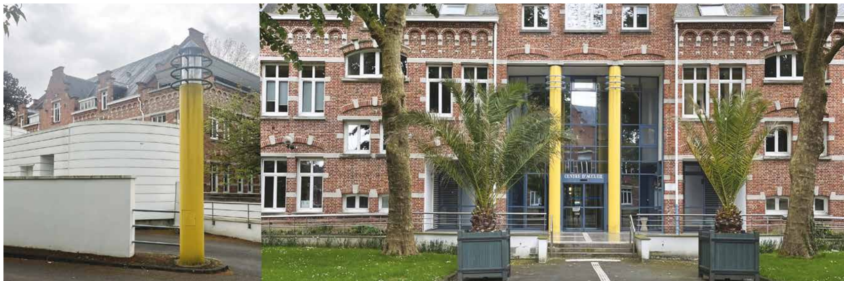
Fig. 18. Photographie des poteaux caractéristiques de l'EPSM 5
