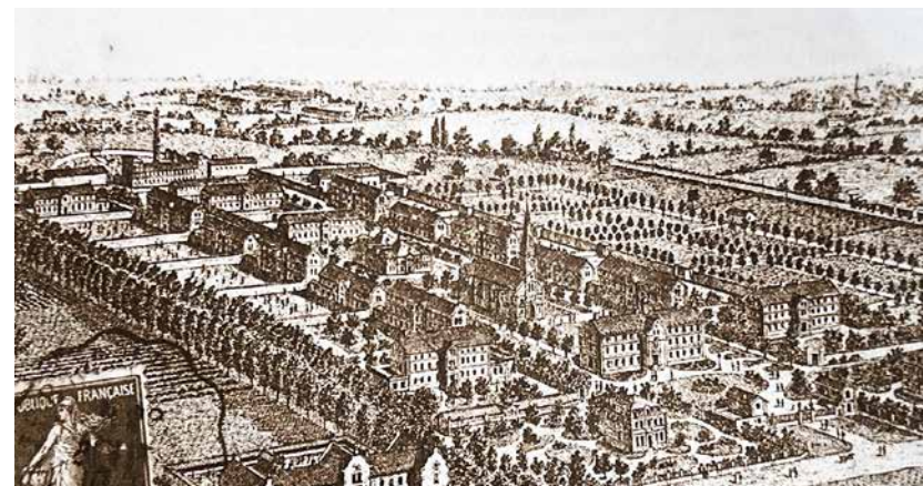
Fig. 4. Vue générale de la Maison de Santé 1
