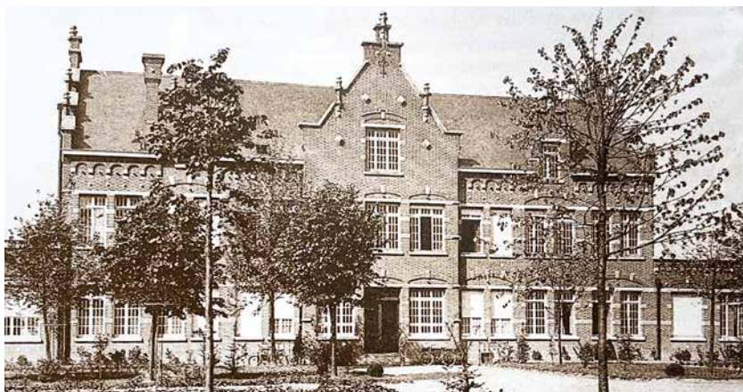
Fig. 9. Facade du pavillon d'administration après la reconstruction de 1951 3
