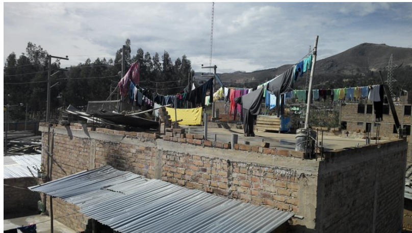
Figure 8 : Toit d'une maison des environs de l'habitat de Sandra. Photo : Caels D. 2017
