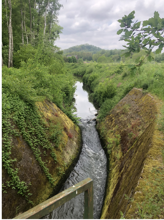
FIGURE 3.4 – Section de la Biesme qui se rétrécit à la confluence.
