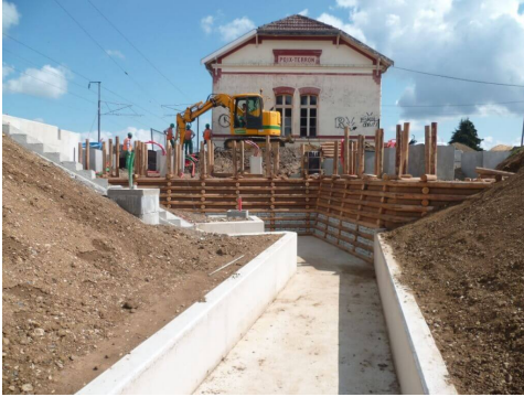
FIGURE 2.2 – Mur de soutènement à la gare de Poix terton (France) réalisé par Dynamique Environnement [29].
