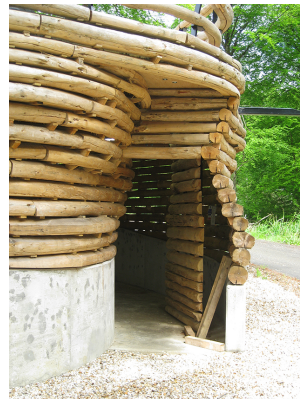
FIGURE 2.5 – Chaufferie dans le "Hooke Park" (Royaume-Uni) réalisée par les étudiants de l' Architectural Association School of Architecture [31].
