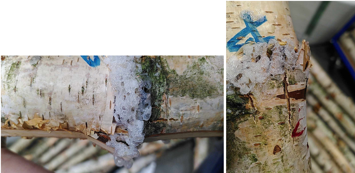
FIGURE 11.11 – Déformations au niveau de l'aboutage de l'essai IV.2 suite au serrage.
