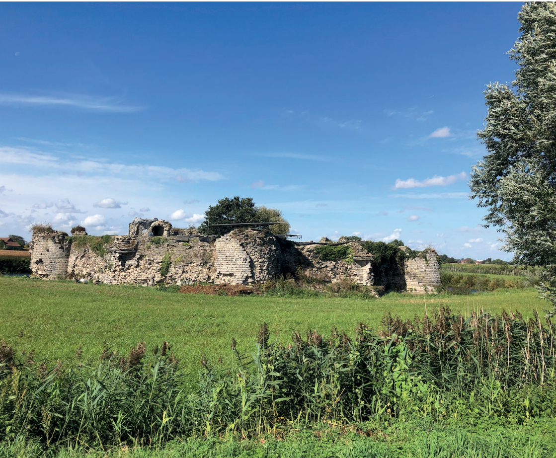
Fig. 21 : Ruines du château de La Royère
