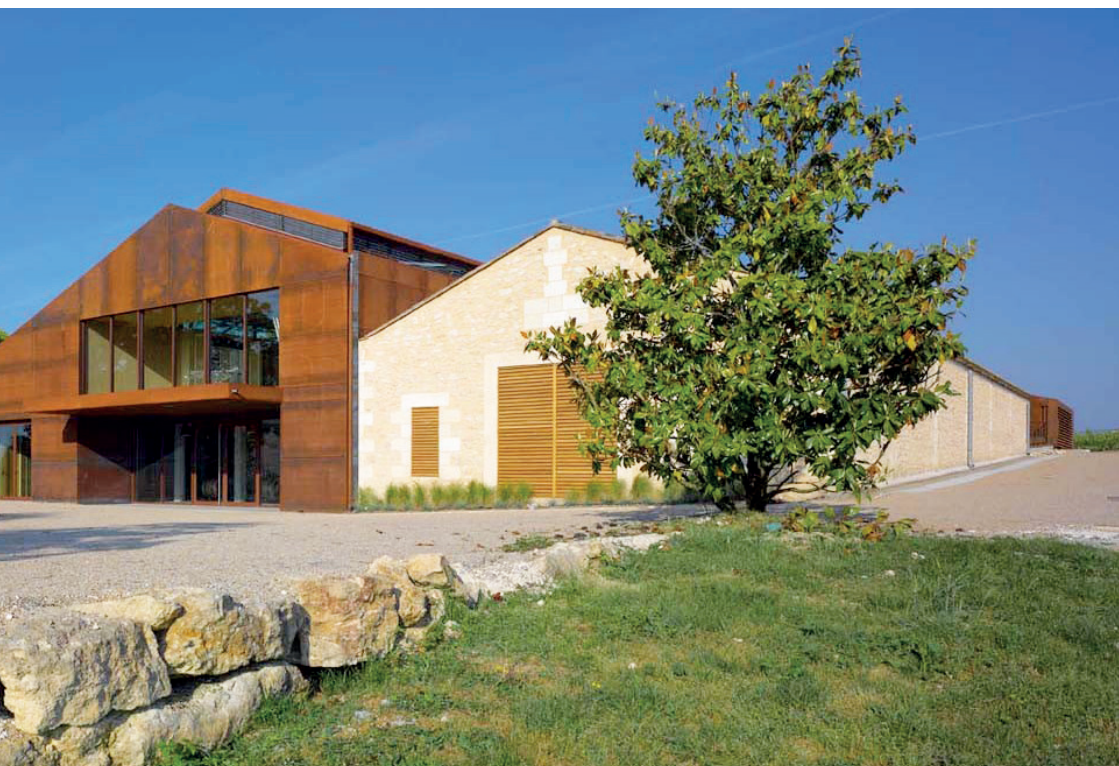
Fig. 14 : Nouveau bâtiment «glissé» entre les deux édifices existants
