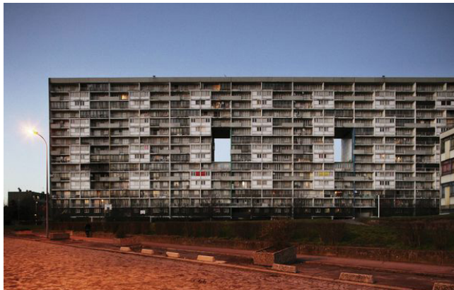
Cyrus CORNUT, La barre Balzac de les cité des 4000 à la Courneuve démolie par grignotage , 2011
