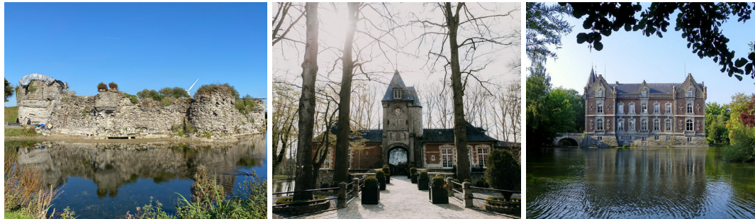
ILL 106 : Photographies récentes du château de la Royère, puis du château du Biez et pour finir du château de Bourgogne
