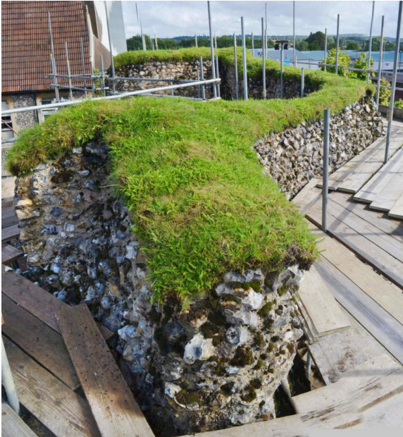
ILL 123 : Système de protection des têtes de mur « soft capping »
