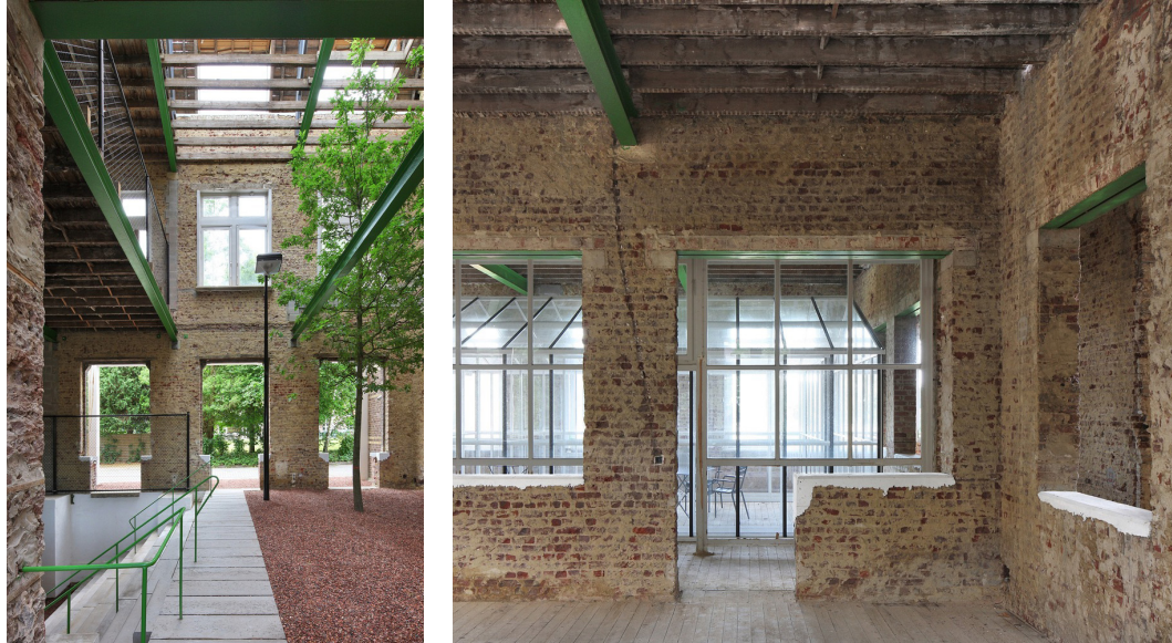
ILL 41 : Les modifications et éléments ajoutés sont facilement différenciables de l'existant.
