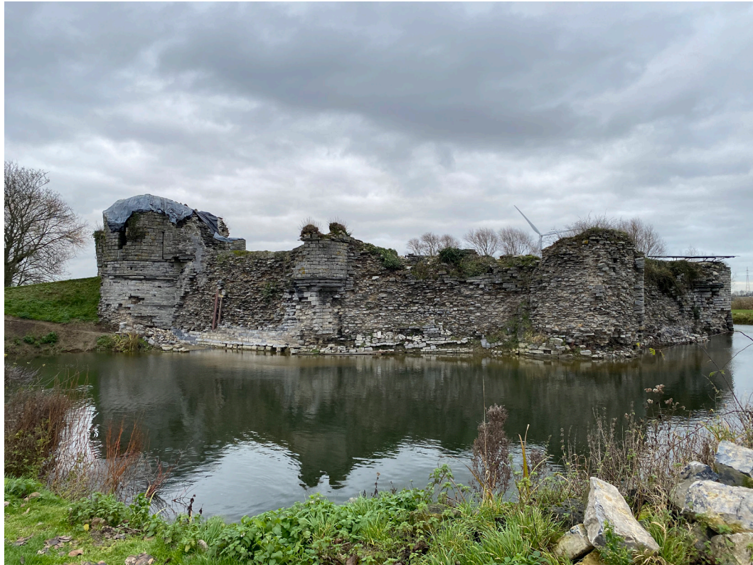
ILL 3 : Photographie du château de la Royère prise en décembre 2021. Ce château se situe dans la commune d'Estaimpuis dans la province de Hainaut en Belgique.
