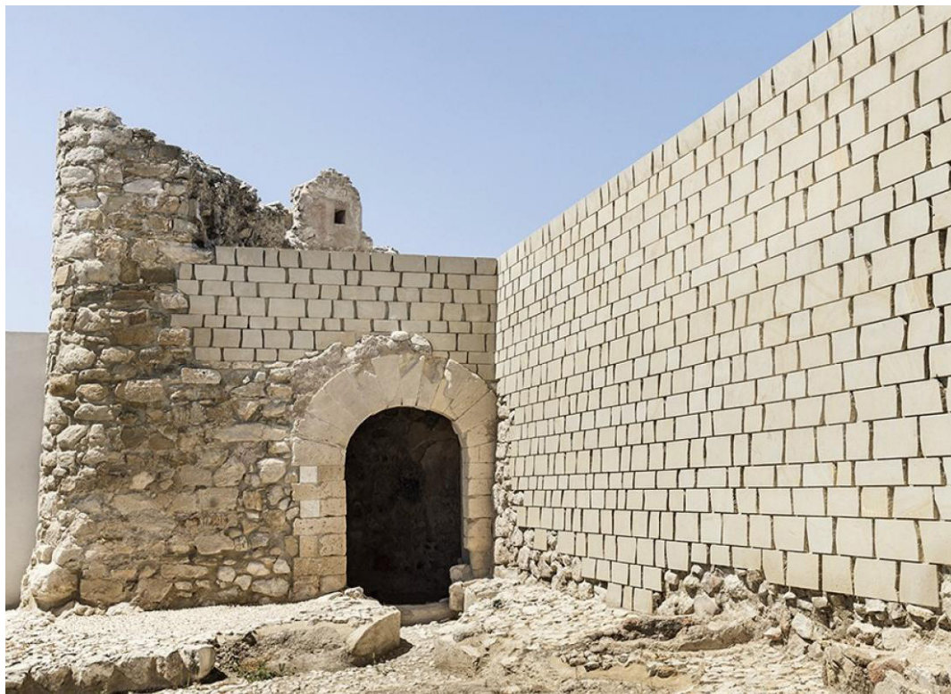
ILL 75 : Photographie du château prise depuis la cour intérieure montrant l'intégration de l'intervention contemporaine aux vestiges.
