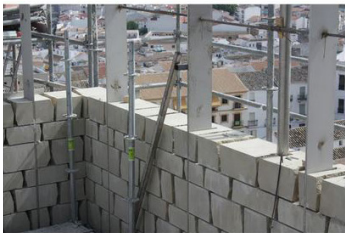
ILL 71 : Planche explicative de la structure entre les murs de maçonnerie et les noyaux en béton
