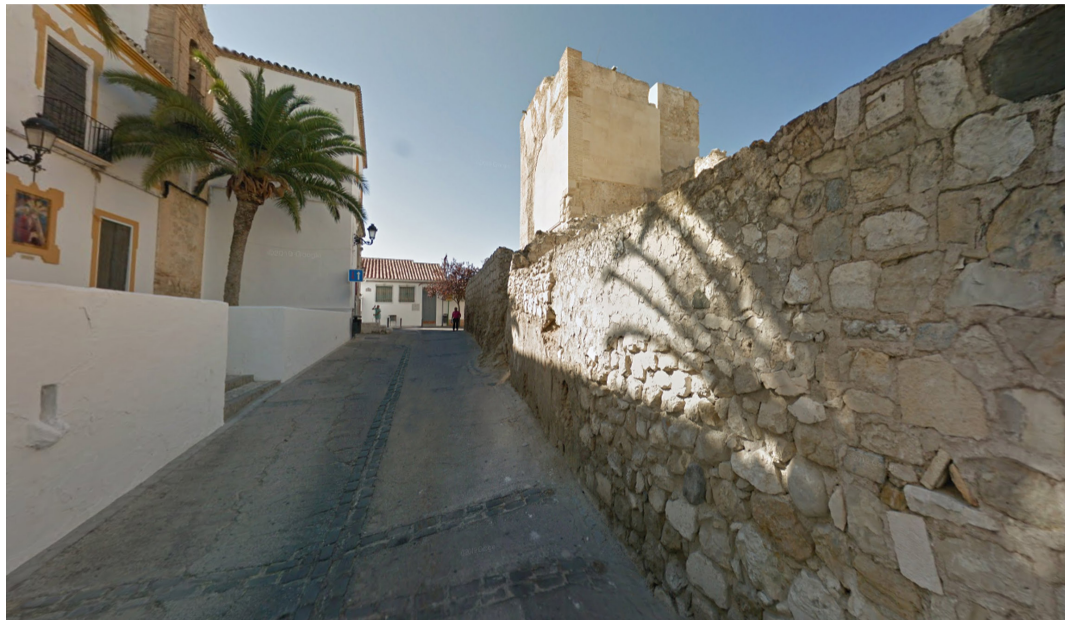
ILL 53 : Le château et son environnement immédiat
