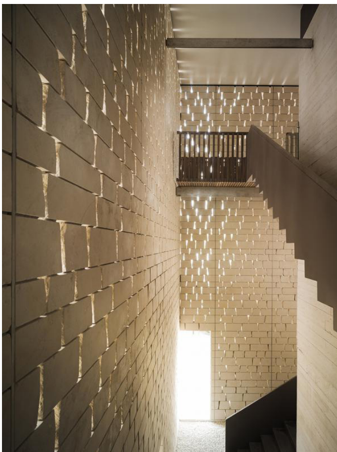
ILL 70 : Mise en œuvre de la maçonnerie pour créer des jeux de lumière
