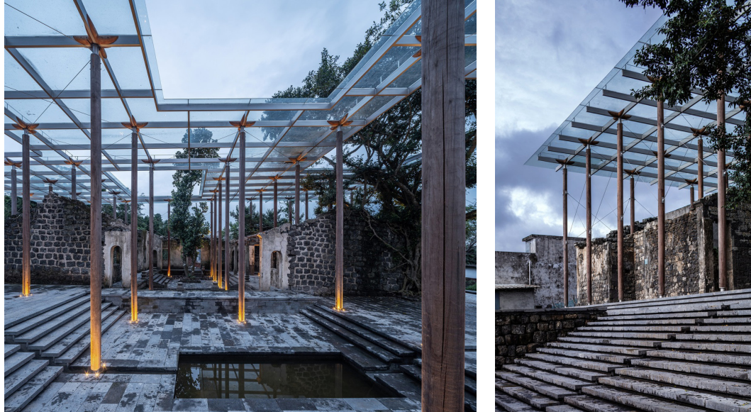
ILL 43 : Protection des ruines par la mise en place d'une toiture
