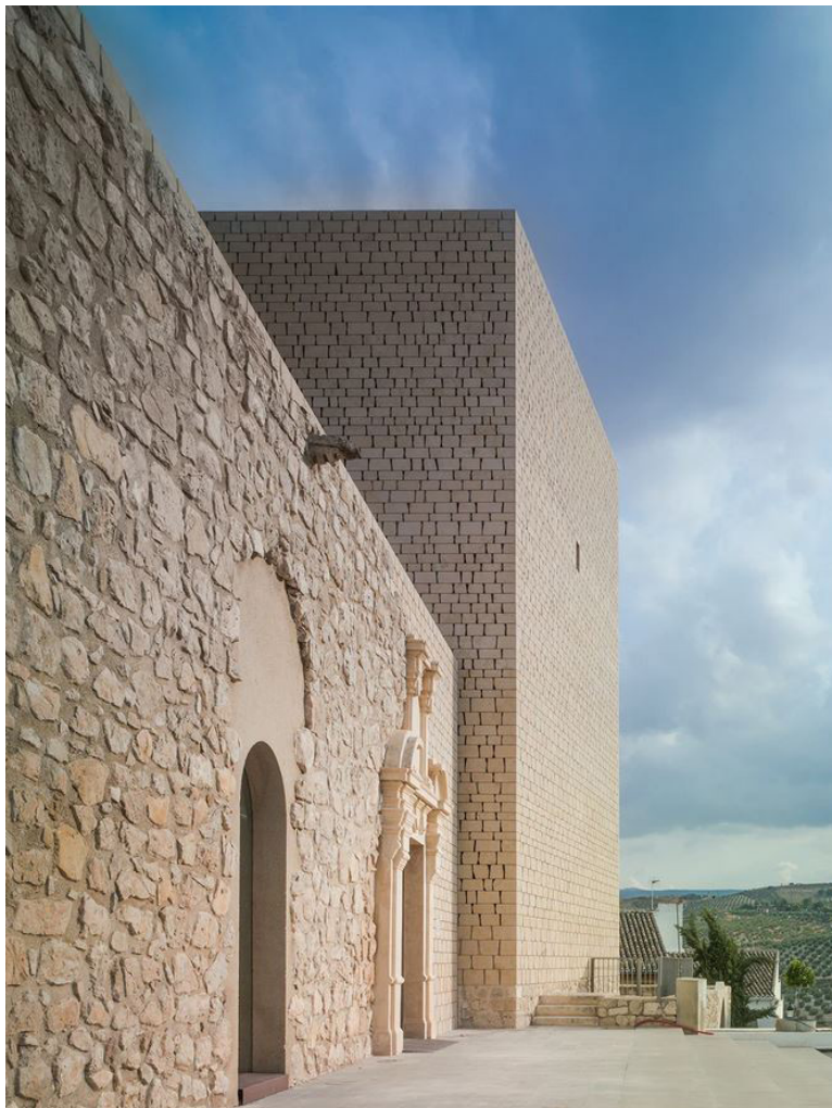
ILL 49 : Photographie du château de Baena prise au niveau de l'entrée côté Ouest
