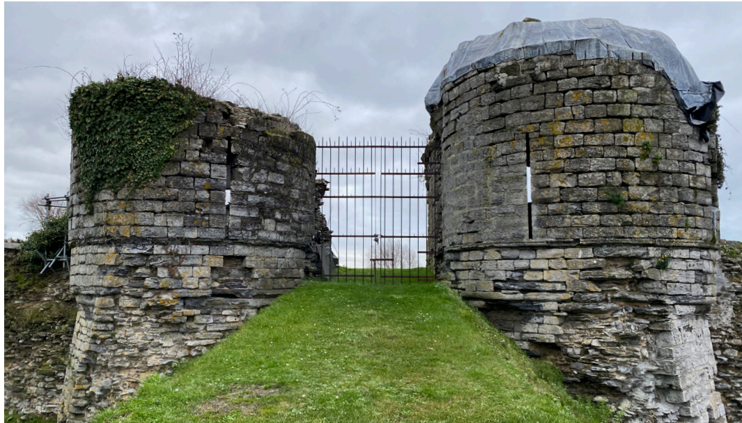
ILL 110 : Photographie illustrant la grille actuelle qui ferme le site du château
