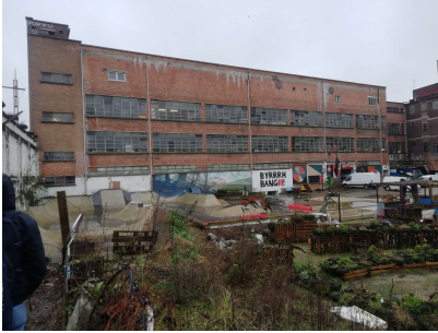
Fig. 19 - Photographie de l'aile Sud
