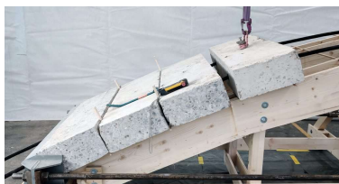
Fig. 9 - Pose des blocs sur un arc en bois. Les câbles de posttension sont déjà disposés (ci-dessus)
