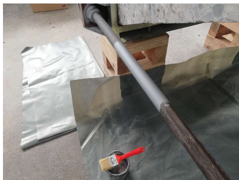
Fig. 11 - Application de l'antirouille sur un des deux tendeurs
