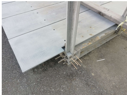
Fig. 14 - Photographie d'une jonction de dalles et de ses tiges filetées M10 en polymère renforcé de fibres et mastiquées
