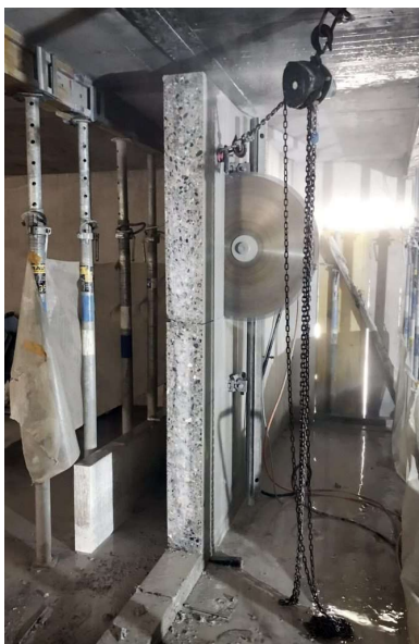
Fig. 8 - Découpe à la scie à diamants des murs en béton armé
