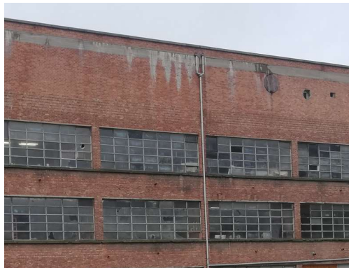
Fig. 27 - Photographie des briques de façade
