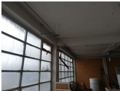
Fig. 28 - Photographie des fenêtres de façade
