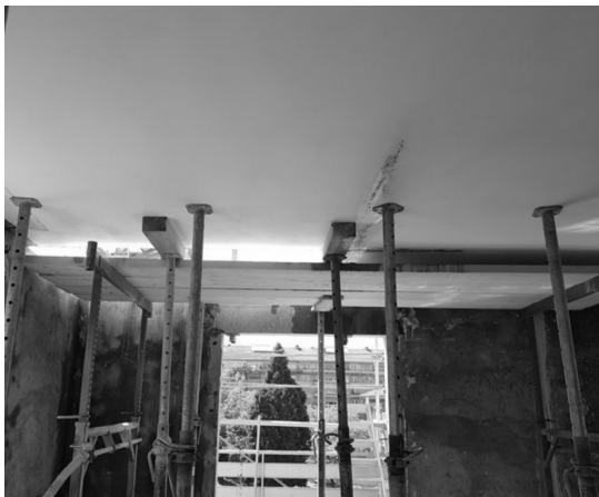
Fig. 7 - Photographie de l'échafaudage et du platelage
