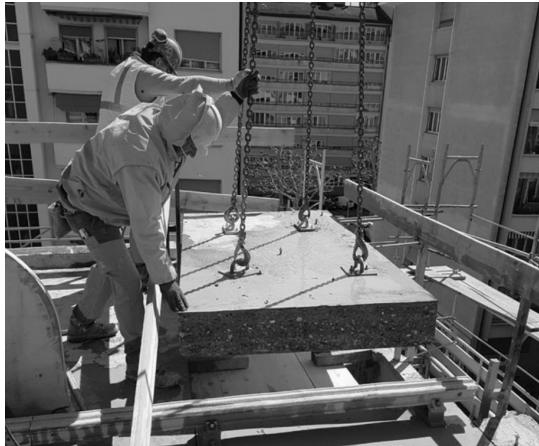
Fig. 6 - Photographie de l'extraction d'une des dalles de béton
