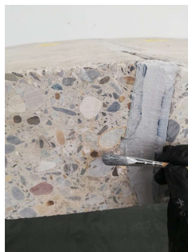
Fig. 12 - Application de l'antirouille sur les barres d'armature apparentes
