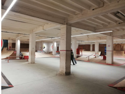
Fig. 26 - Photographie de la structure poteaux-dalles en béton armé coulé sur place
