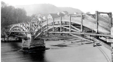
Fig. 1 - Photographie du pont en bois à Eglisau
