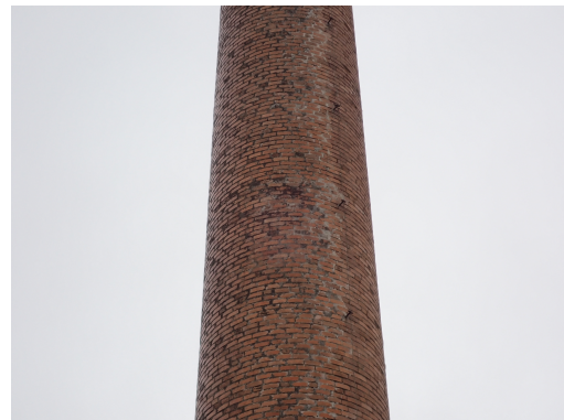
(d) Repaired crack.
