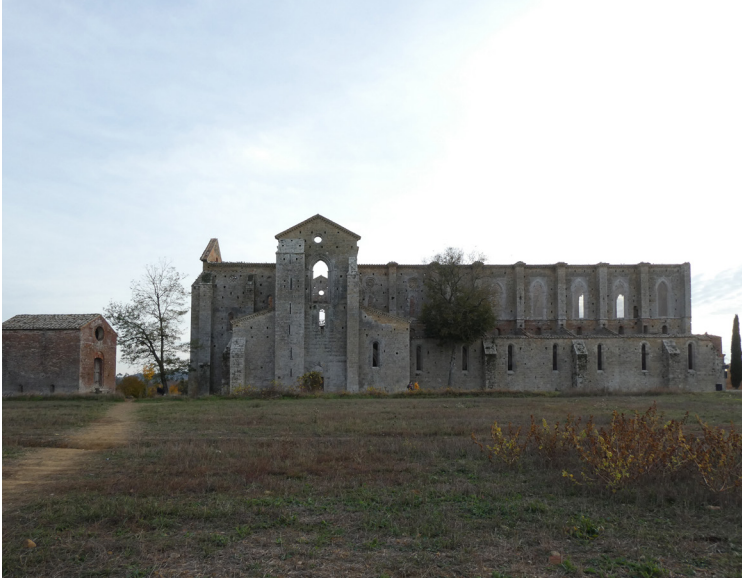
fig 66 : La façade sud de l'église
