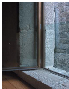
fig 34 : Le châssis encastré
