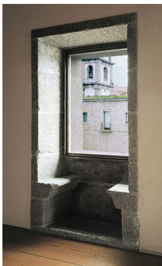
fig 38 : Assises dans l'épaisseur du mur
