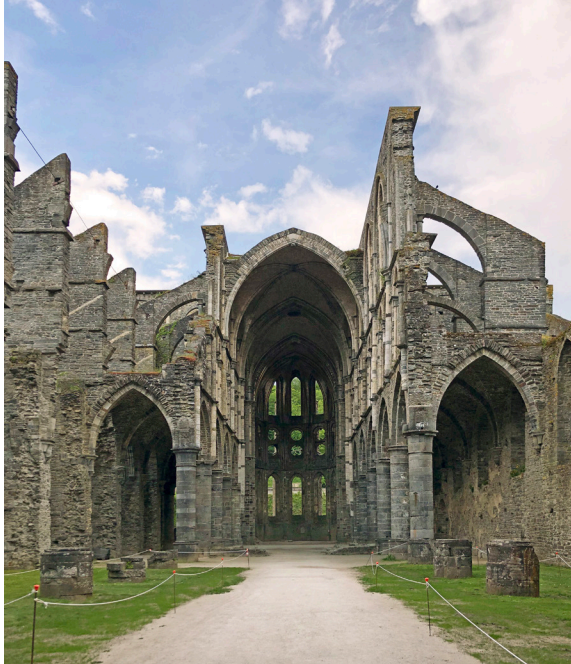
fig 16 : Les vestiges de l'église
