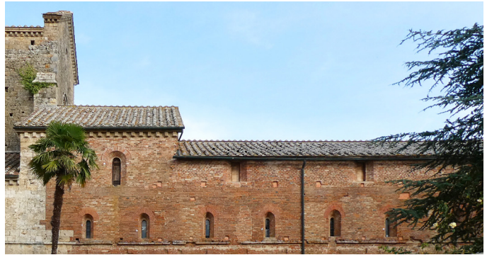
fig 48 : Façade du dortoir
