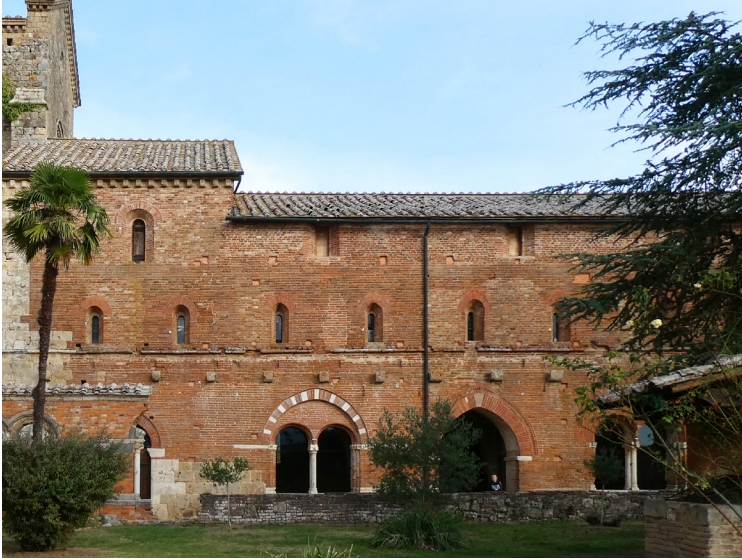
fig 32 : Façade de l'aile orientale la salle capitulaire au rez Le dortoir au 1er étage
