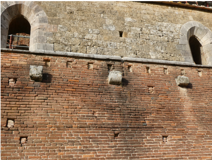
fig 24 : Les corbeaux et trous d'encrage de l'ancienne toiture
