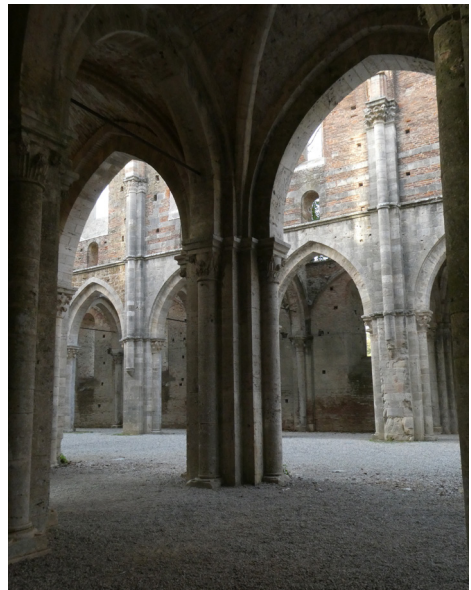
fig 65 : Les voutes d'ogives préservées et restaurées
