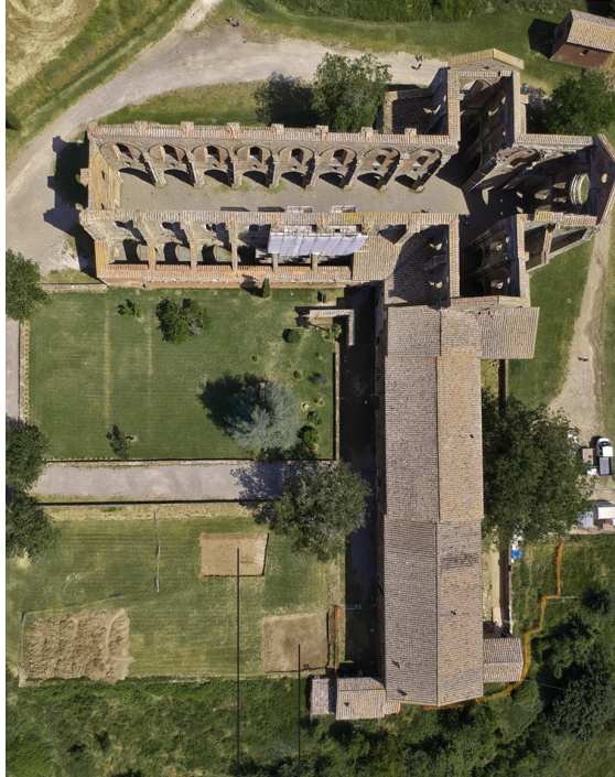
fig 44 : Vue aérienne du site
