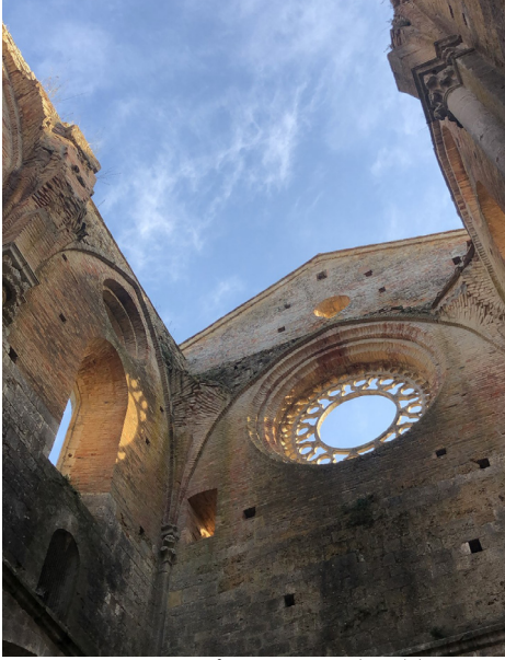
fig 62 : Rosace, aile sud du transept
