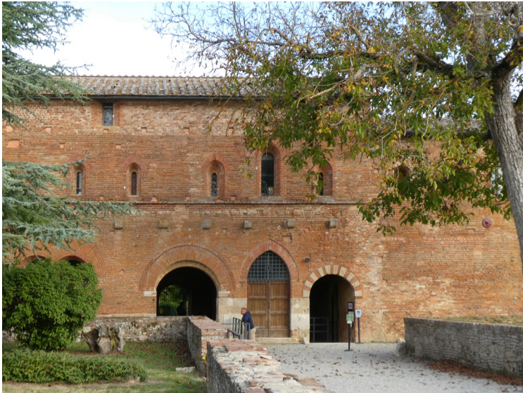
fig 28 : Façade de l'aile orientale : la porte du parloir, la porte de l'escalier et l'arche de passage
