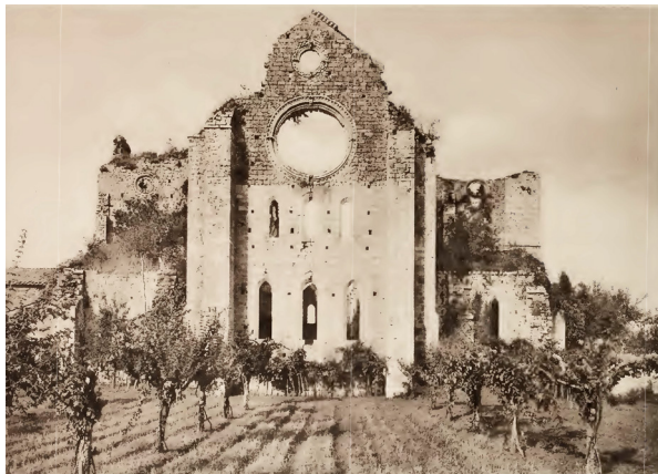
fig 41 : La façade est ruinée (1896)
