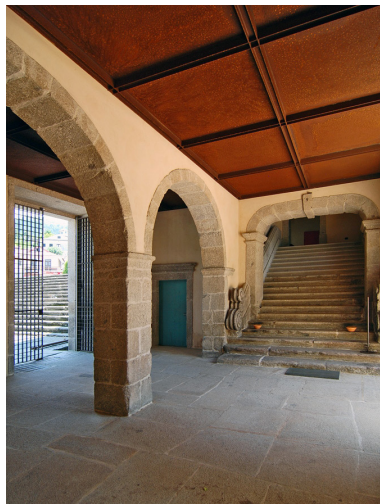
fig 40 : Le hall d'entrée, plancher caisson acier corten
