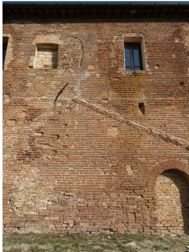
fig 50 : Appareillage briques en diagonal
