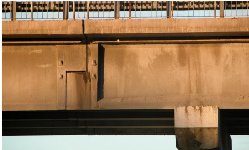
Figure 4: Console du pont de San Nazzaro [6]
