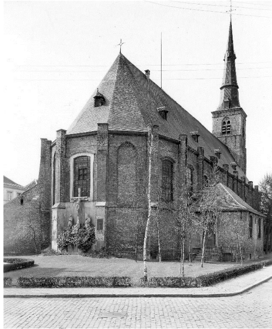
Fig. 63. Bruges, église Sainte-Anne, vue extérieure de l'abside, XV-XVI e siècle. État en 1953.
