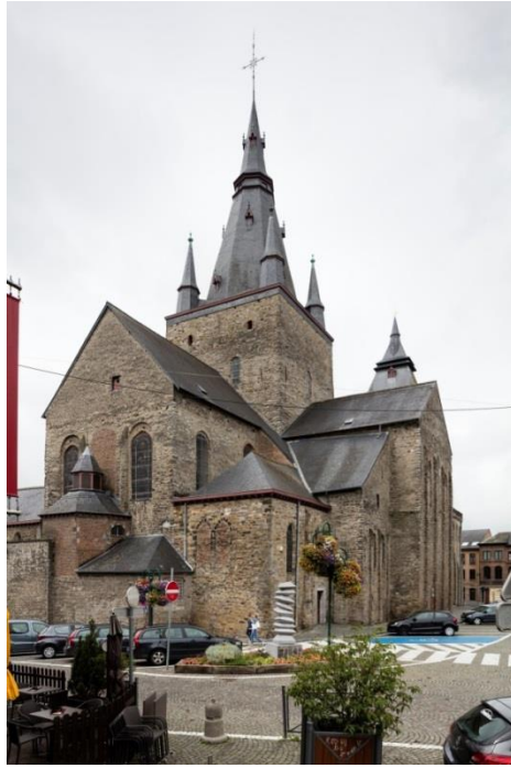
Fig. 65. Soignies, collégiale Saint-Vincent, vue extérieure de l'abside, X-XVIII e siècle. État en 2016.
